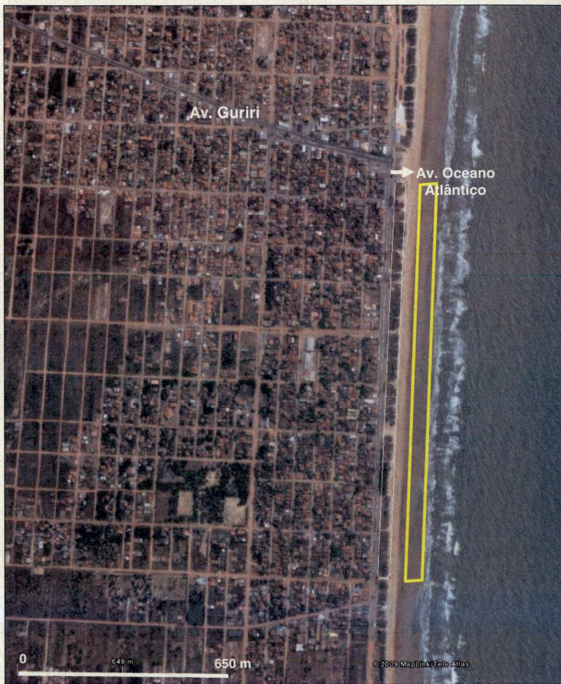
Figura II.1.2 - Área a ser recuperada na orla de Guriri, município de São Mateus (ES) – marcação em amarelo. Escala 1:10.000. Imagem: Google Earth
