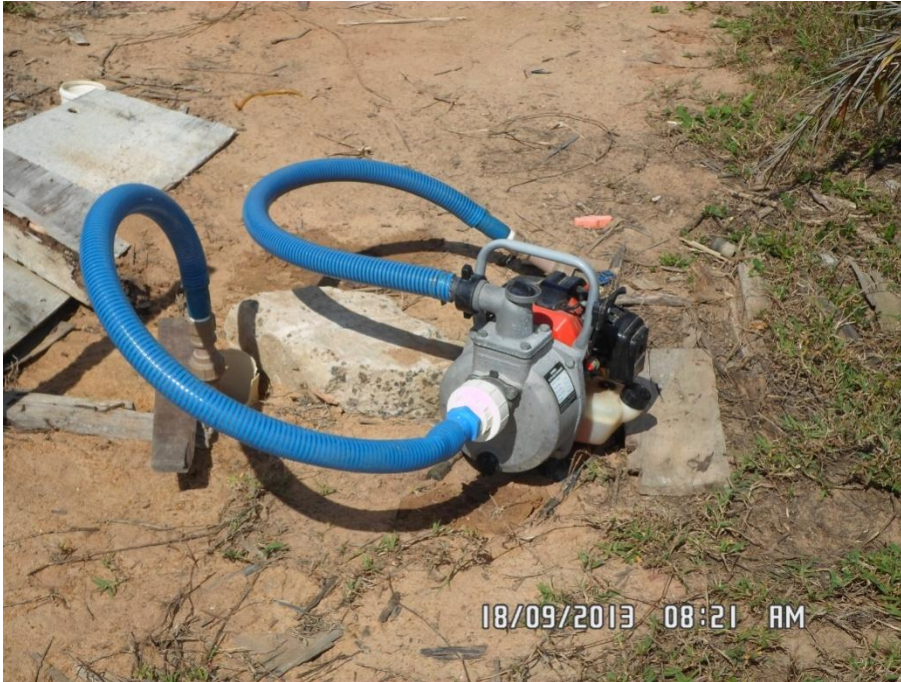
Figura III.2.1-2 - Motobomba utilizada para a captação de água do poço na restinga de Guriri, ES.
