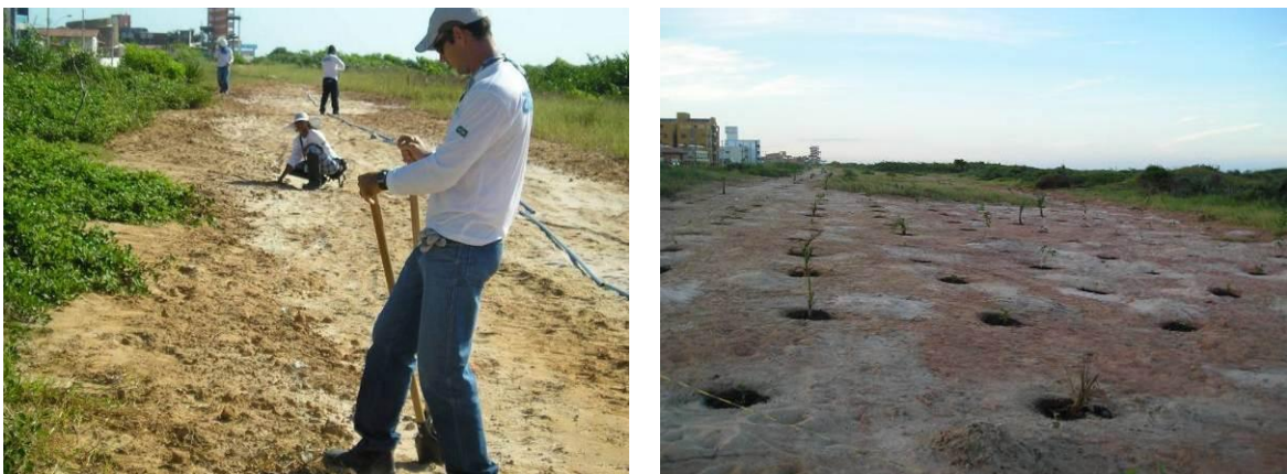
Figura 16: Aplicação da metodologia em linha com o auxílio de uma corda demarcada a cada 2 metros.
