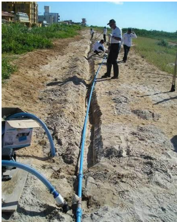
Figura 8: Montagem do primeiro e segundo sistemas de irrigação.
