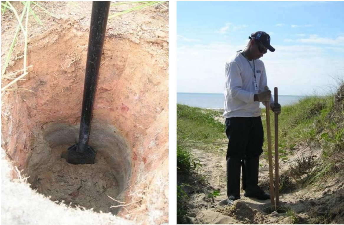
Figura 18: Abertura do berço utilizando-se cavadeira plana e articulada.
