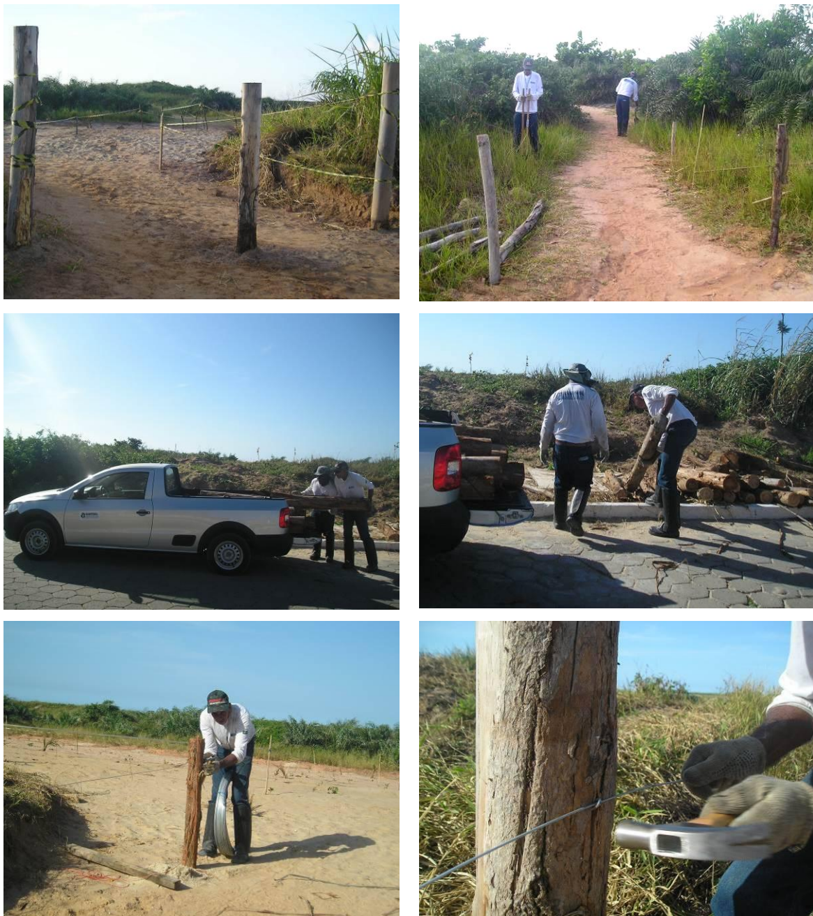
Figura 25: Cercamento da área onde foi executado o PRAD.
