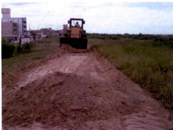
Figura 3: Retirada da argila da área de recomposição vegetal auxiliada por uma retroescavadeira da Secretaria de Obras da Prefeitura de São Mateus.
