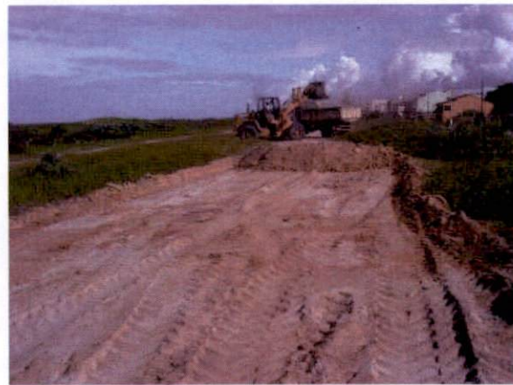
Figura 3: Retirada da argila da área de recomposição vegetal auxiliada por uma retroescavadeira da Secretaria de Obras da Prefeitura de São Mateus.
