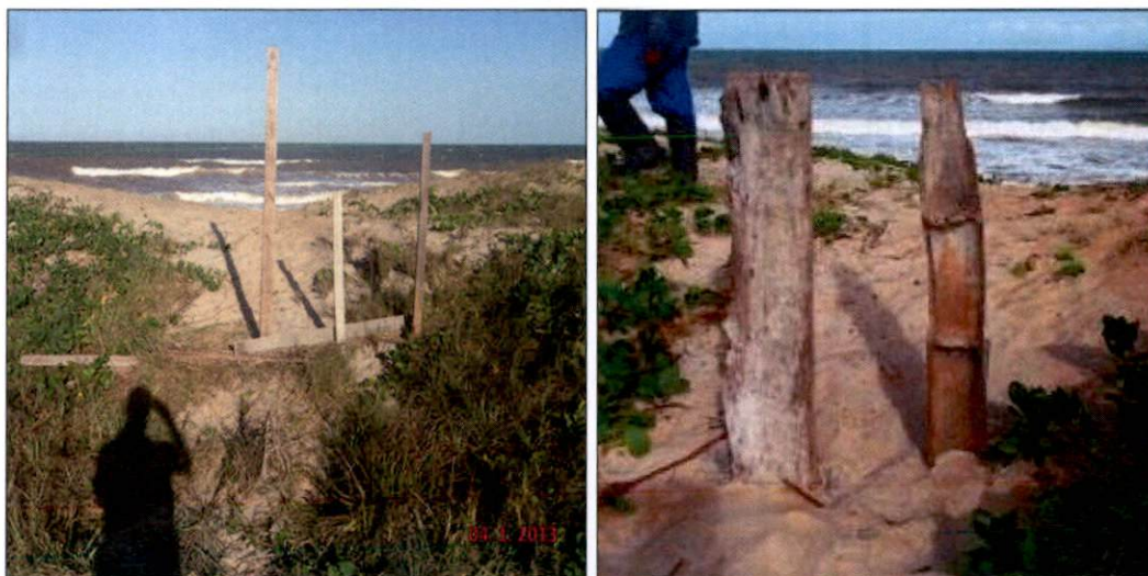
Figura III 3-4 – Obstáculos colocados na passagem de banhista, a fim de diminuir a entrada de pessoas e carros na área.
