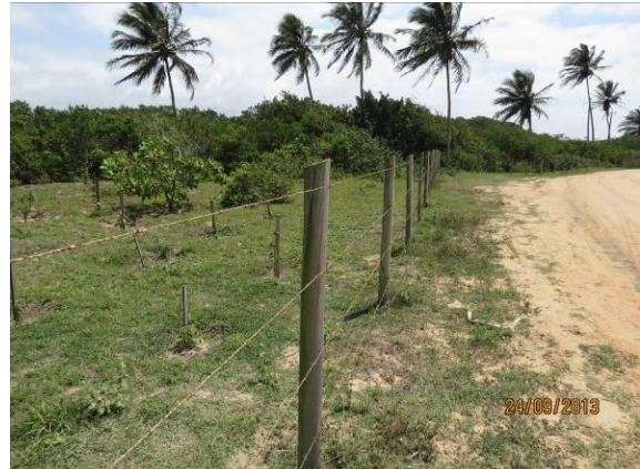
Figura III.2.7-2 - Cerca de proteção da cortina vegetal apresentando bom estado de conservação.
