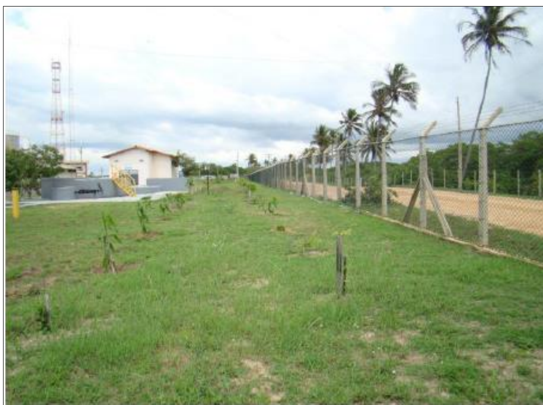
Figura VI-4 – Vista da cortina vegetal do TNC (lado norte) em março de 2011.
