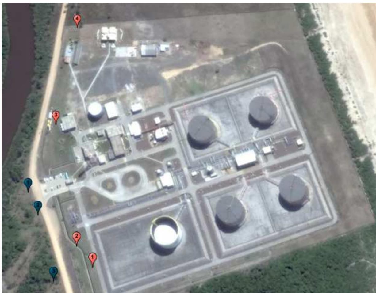
Figura 4: Imagem aérea da área de monitoramento e manutenção no Terminal Norte Capixaba – São Mateus – ES, com os pontos das parcelas de monitoramento. Pontos de 1 a 4 em vermelho – cortina vegetal. Pontos 1 a 3 em azul – área externa. Fonte: Google Earth Pro, data 09/07/2015.
