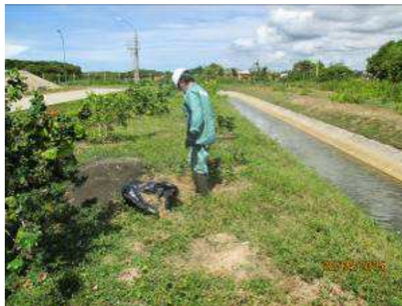
Figura 37: Colocação de cobertura morta na cortina vegetal área interna do TNC.
