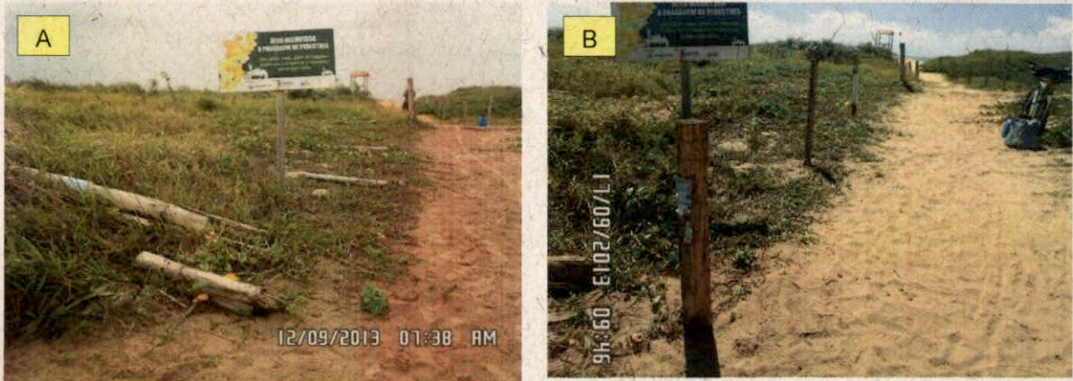
Figura III.2.7-1 - Apresentação da área antes (A) e depois (B) da restauração da cerca de proteção da área de revegetação da restinga de Guriri, ES.
