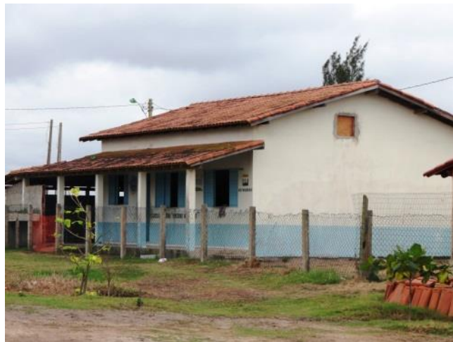
Figura 13 - Escola Barra Nova Sul.
