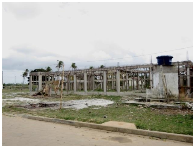
Figura 12 - Nova unidade de Nativo em construção.
