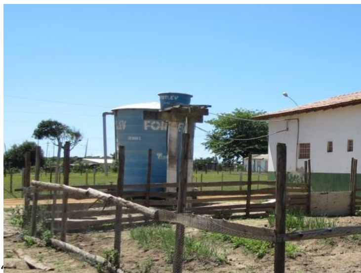
Figura 20 - Caixa de água central em Campo Grande.
