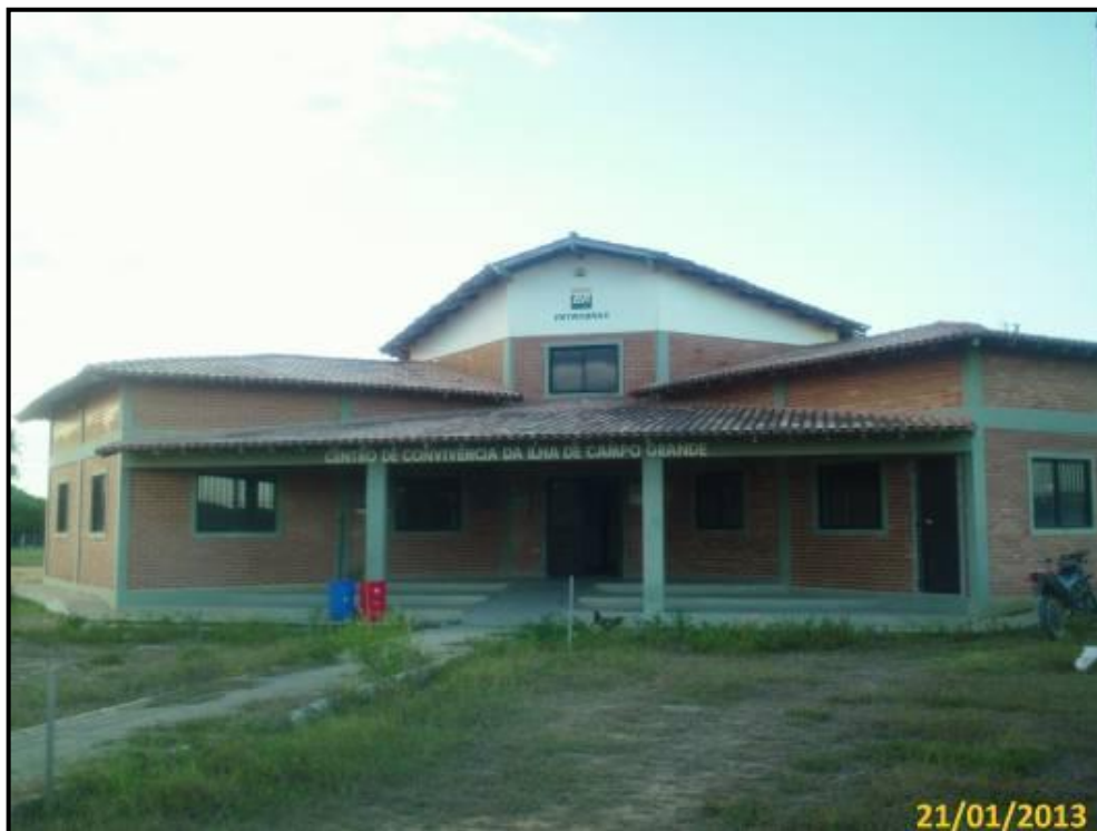
Figura III.1.3-12 - Imagem do Centro de Convivência.
