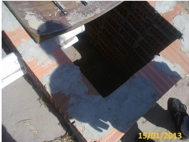
Figura 4-17: Fossa em construção.
