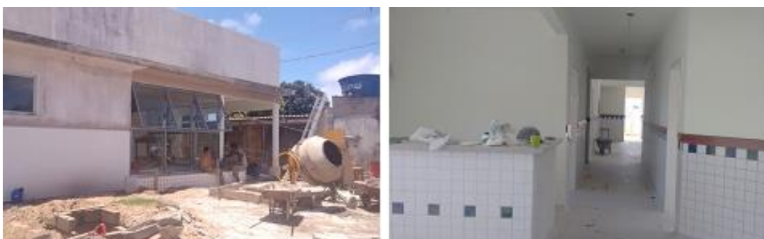
Figura 4-5: Unidade de Saúde de Nativo em Construção
