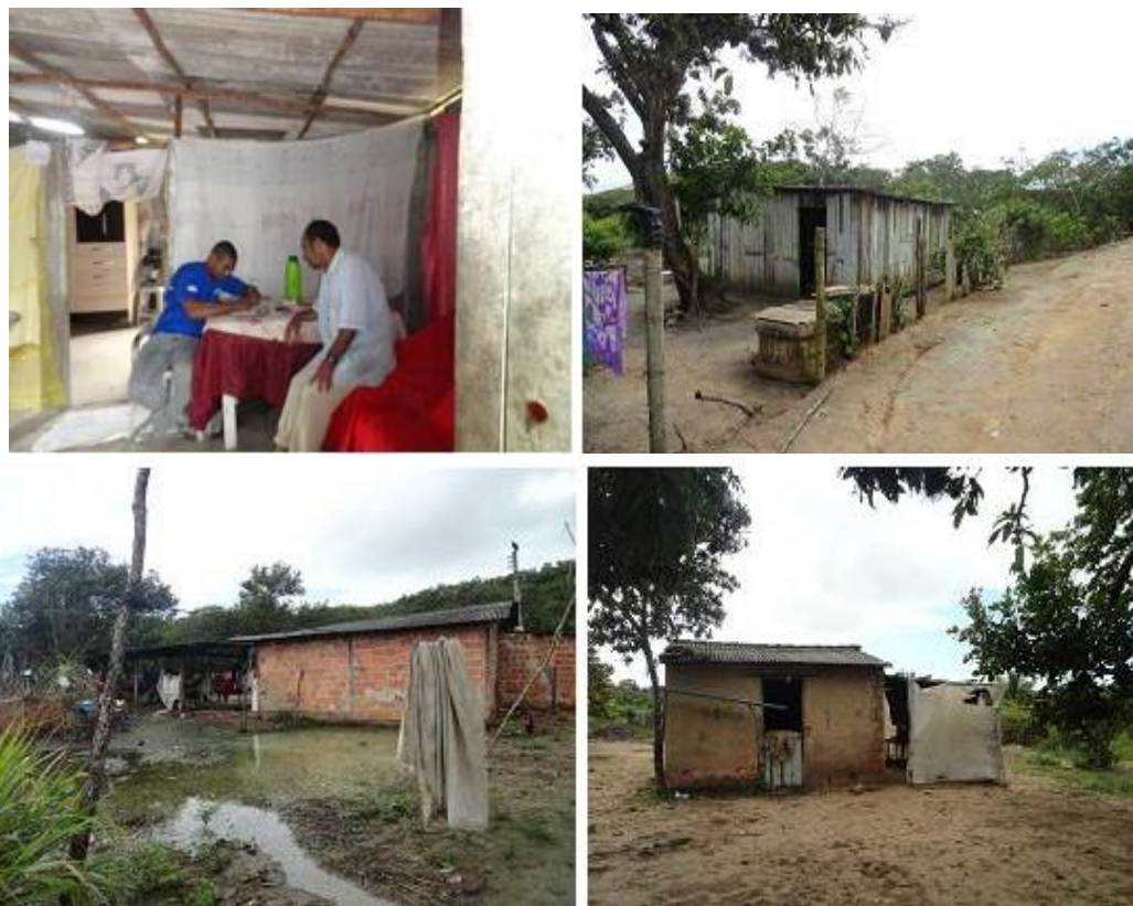
Figura 4-46: Residências em condições precárias – Gameleira Fonte: Programa de Monitoramento Socioeconômico, CTA 2014/2.
