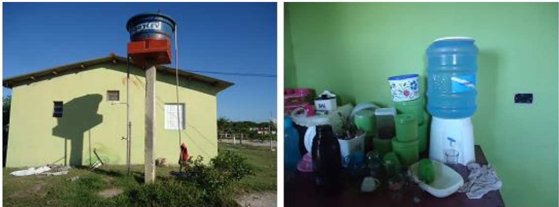
Figura 4-19: Fonte de água – Campo Grande
