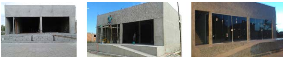
Figura 3-10: Etapas de construção comercial – Barra Nova Sul
