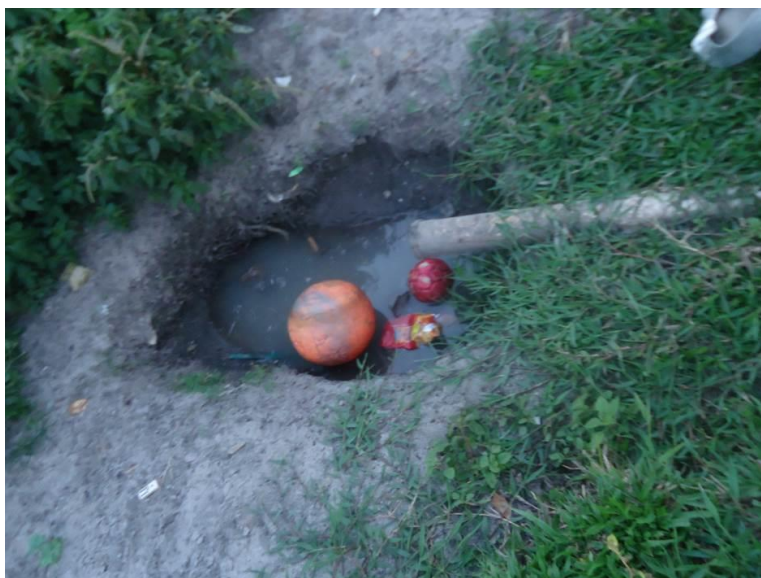
Figura 3-55: Fossa rudimentar – Barra Nova Sul
