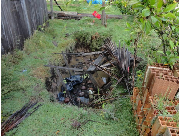
Figura 3-53: Fossa rudimentar – Barra Nova Norte
