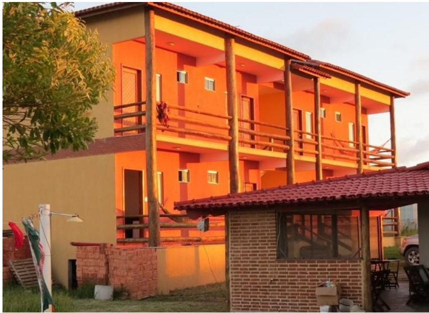
Figura 5-17: Pousada Guruça - Barra Nova Sul Fonte: Registro de campo 2014
