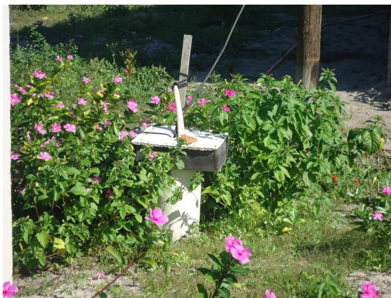
Figura 3-34: Poço/Bomba – Barra Nova Norte
