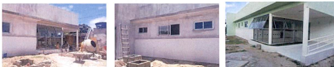
Figura 3-11: Etapas de construção de unidade de saúde – Nativo
