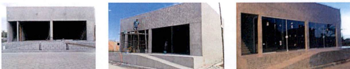
Figura 3-10: Etapas de construção comercial – Barra Nova Sul
