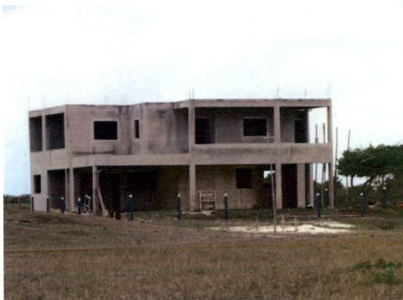
Figura 7 - Casa em construção na Comunidade de Campo Grande
