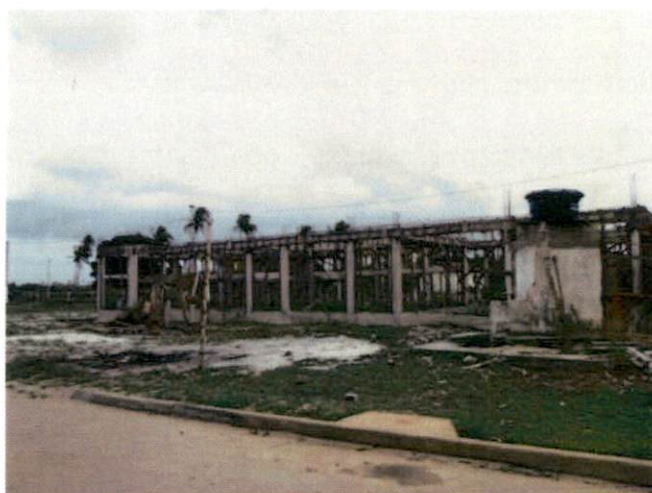
Figura 12 - Nova unidade de Nativo em construção.
