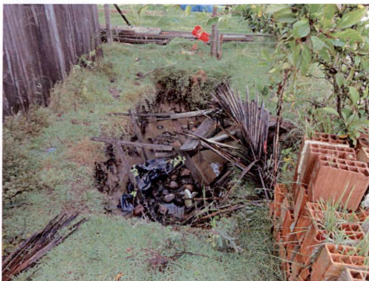
Figura 3-53: Fossa rudimentar – Barra Nova Norte
