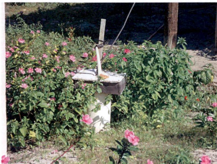
Figura 3-34: Poço/Bomba – Barra Nova Norte
