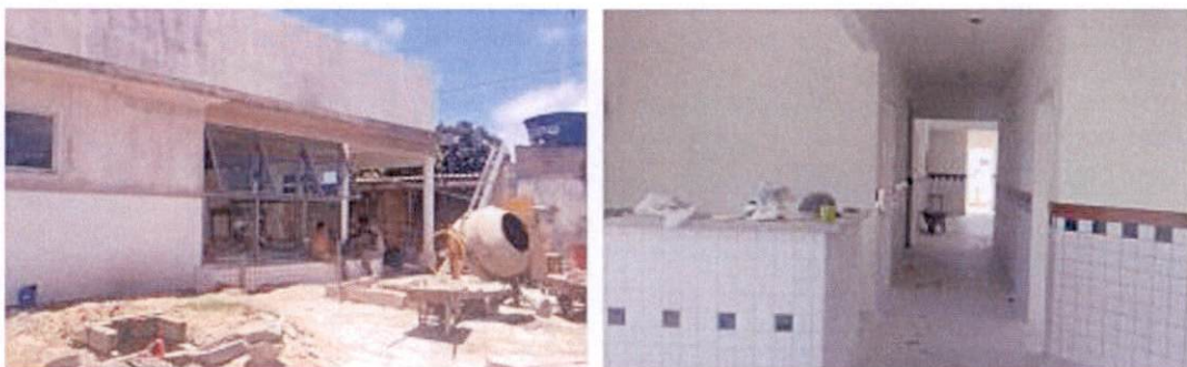
Figura 4-5: Unidade de Saúde de Nativo em Construção
