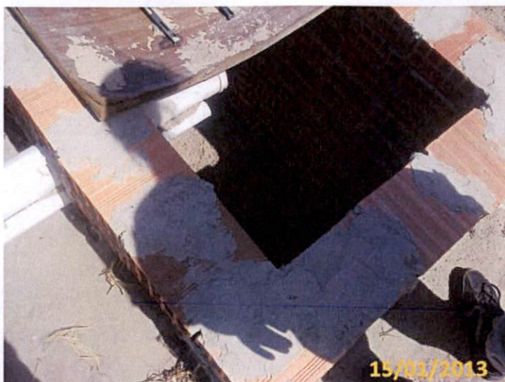
Figura 4-17: Fossa em construção.
