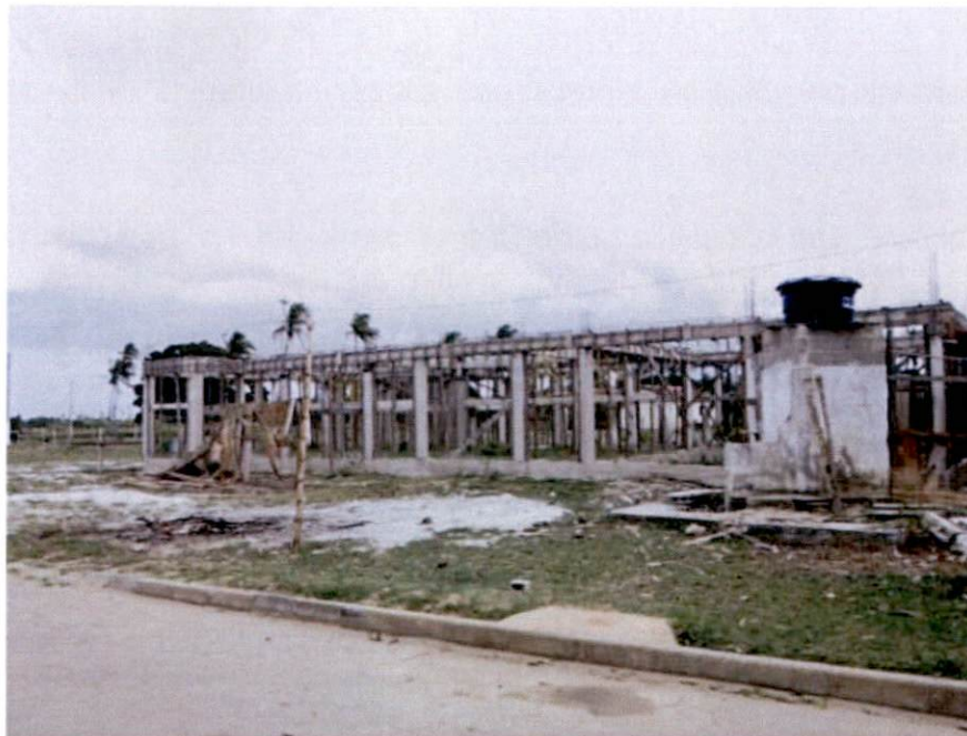
Figura 3-4: Nova unidade de Nativo em construção Fonte: Relatório semestral de Monitoramento Socioeconômico, 2013.
