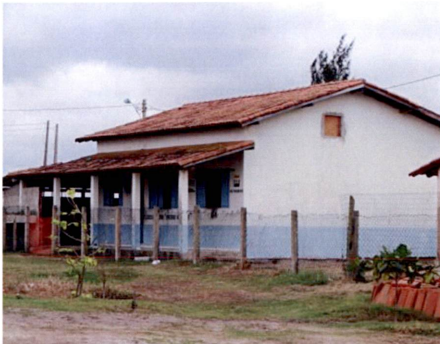
Figura 3-7: Escola Barra Nova Sul
