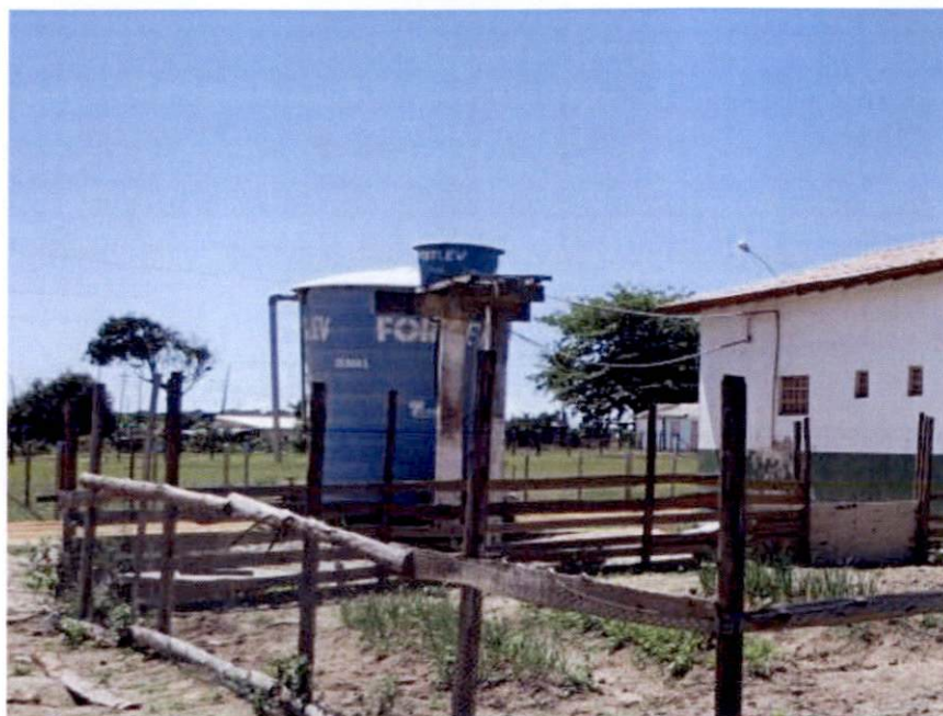
Figura 3-8: Caixa de água central em Campo Grande
