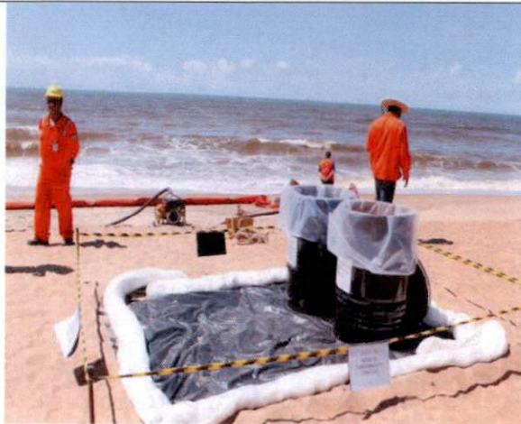
ÁREA DE RESÍDUOS
