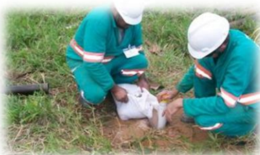
Acabamentos do poço
