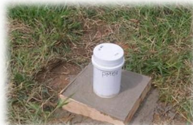
Poço de Monitoramento finalizado
