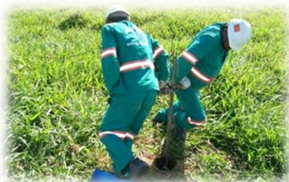
Processo de sondagem
