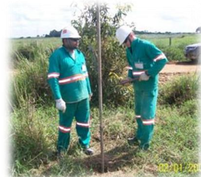
Processo de sondagem
