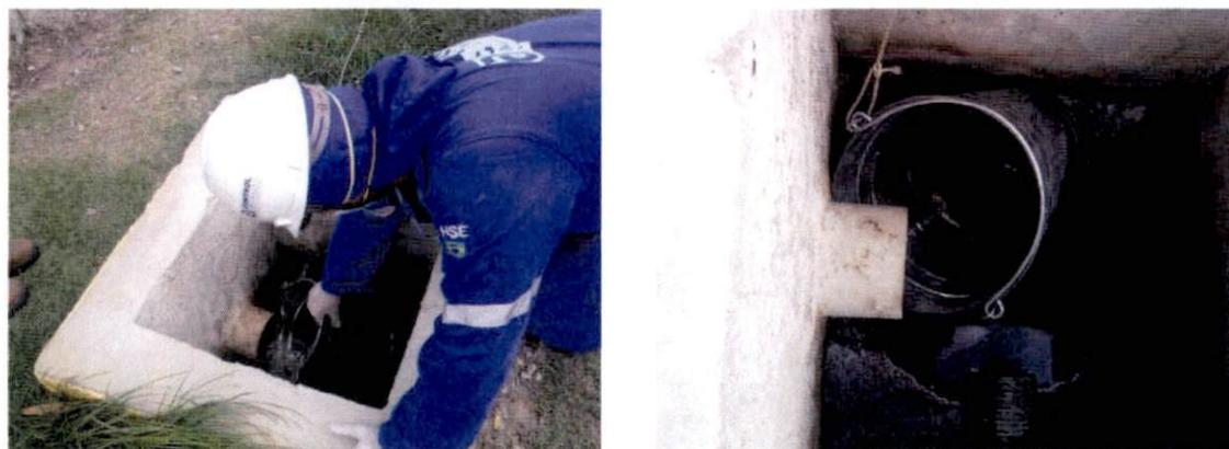
Figura 4-3: Medição da vazão
