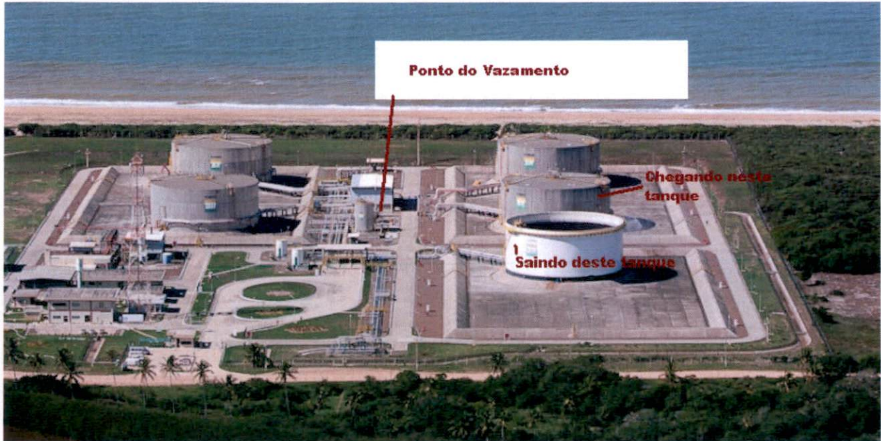
Localização do vazamento.
