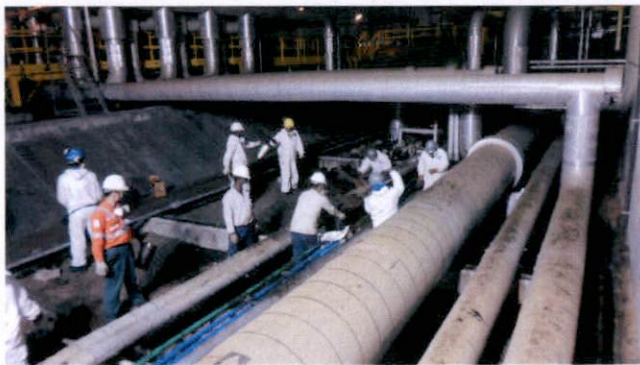
Continuação dos trabalhos noite 30/08/2013
