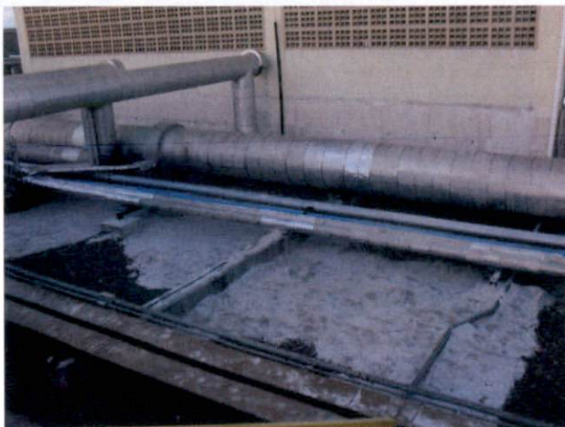
Finalização dos trabalhos no sábado 31/08/2013
