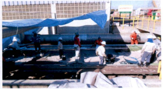
Continuação dos trabalhos 31/08/2013
