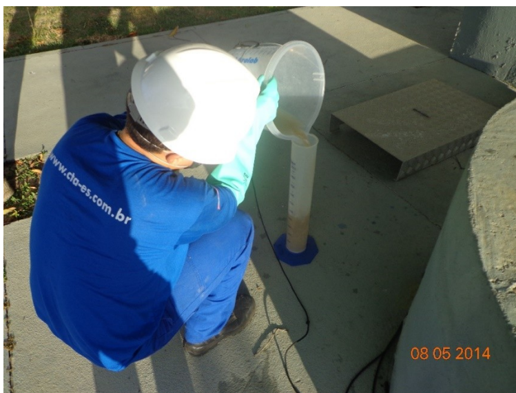
Figura 6-5: Medição de vazão na elevatória da ETE (Entrada) com auxílio de corda e balde.
