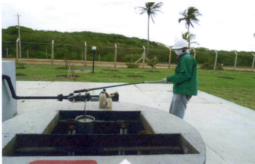
Figura 6 - Coleta na entrada da Estação de Tratamento de Efluentes do TNC (Elevatória)
