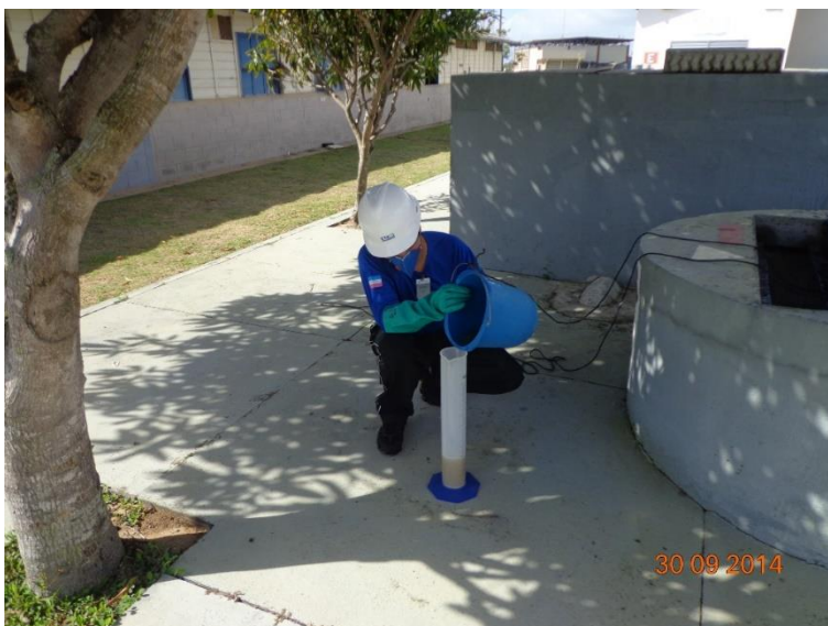
Figura 5-3: Medição de vazão na elevatória da ETE (Entrada) com auxílio de corda e balde.
