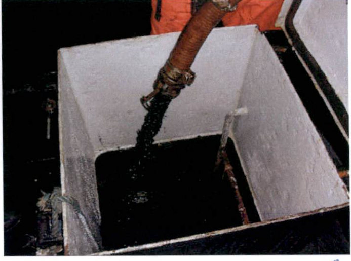
Balsa Hydra Port – Limpeza interna dos mangotes com bomba diafragma
