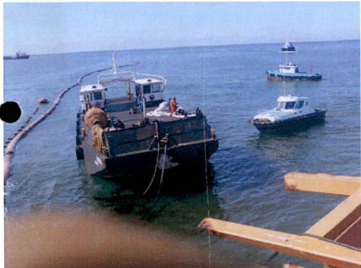
Local da ocorrência – 21/06/2011 - Detalhe: balsa Hydra Port
