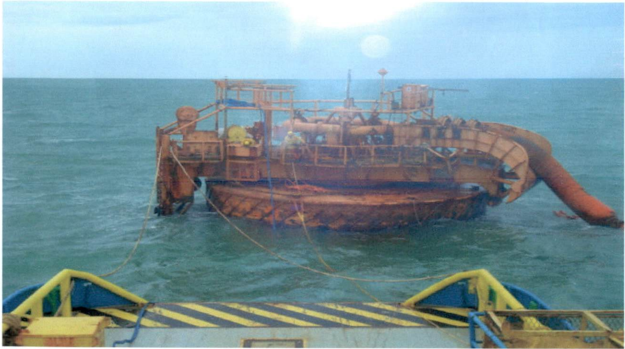
FOTO DA MONOBÓIA APÓS A APLICAÇÃO DE BARREIRA ABSORVENTE
