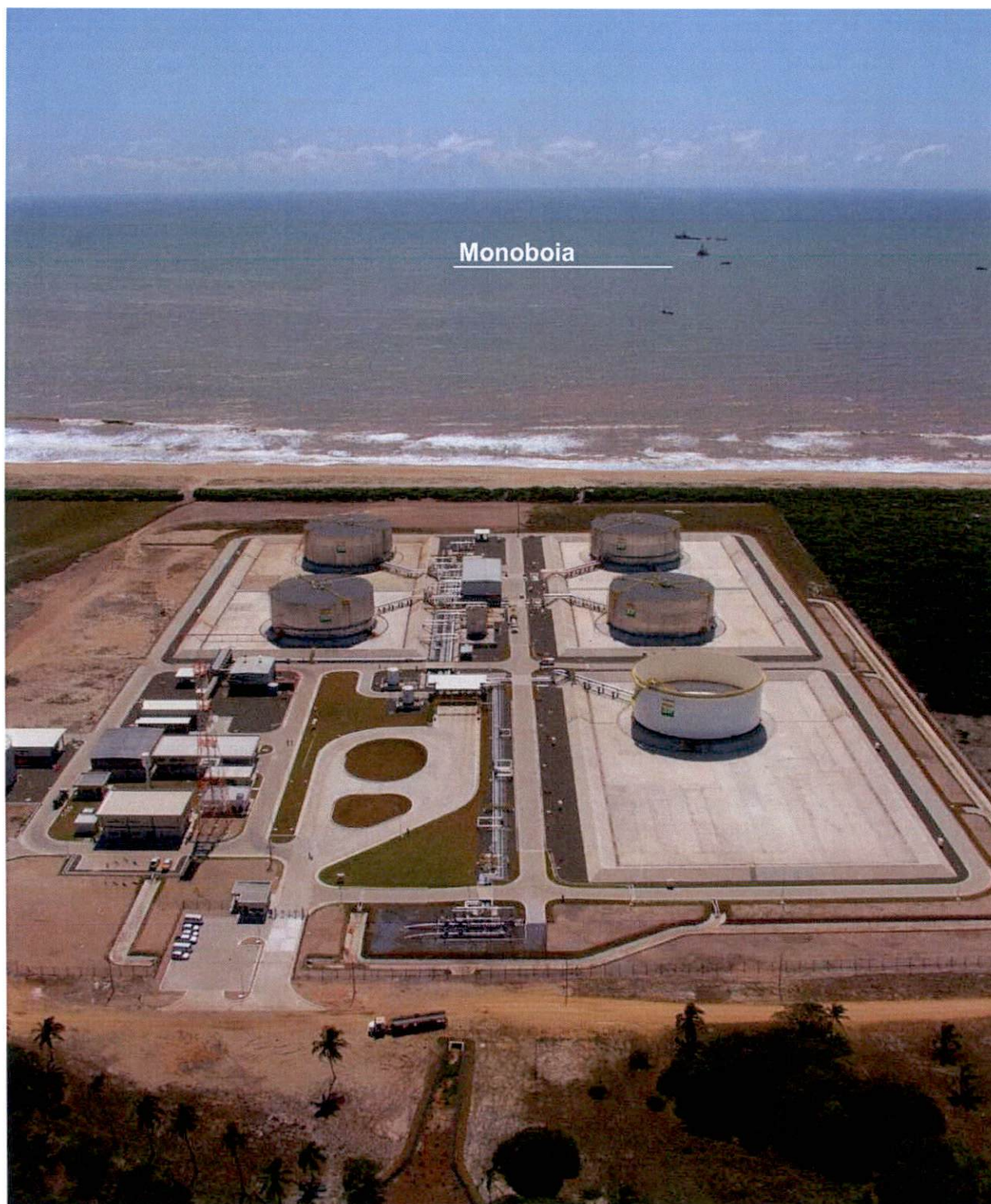
Fig. 1 – Vista aérea do Terminal Norte Capixaba (TNC)
