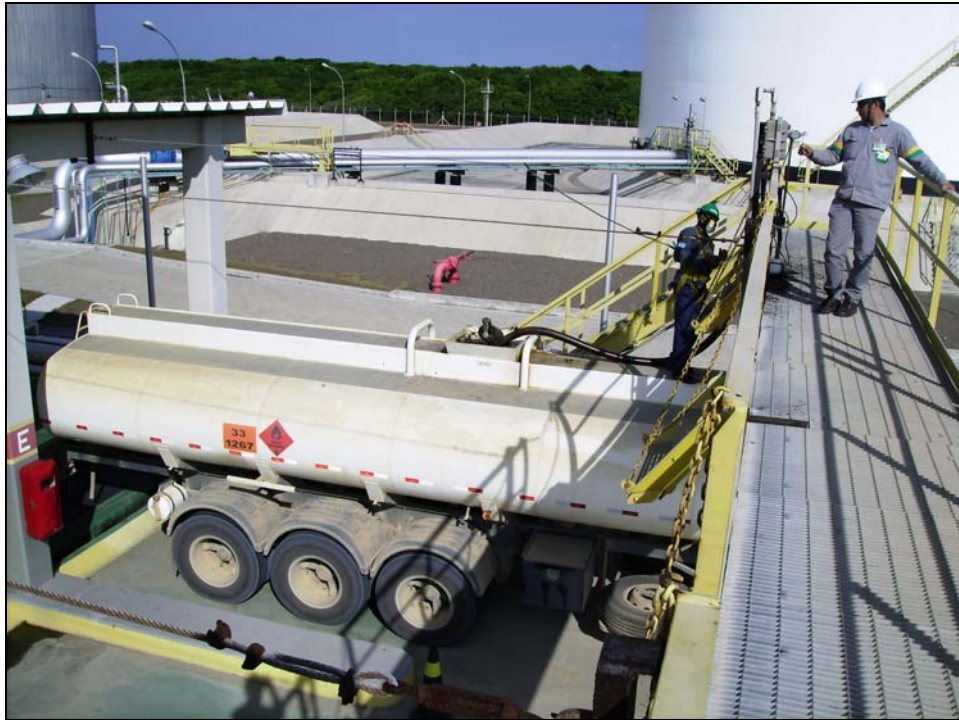
Foto 13 – Plataforma de carregamento de caminhões-tanque
