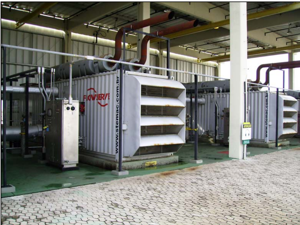
Foto 10 – Bombas de transferência para navios
