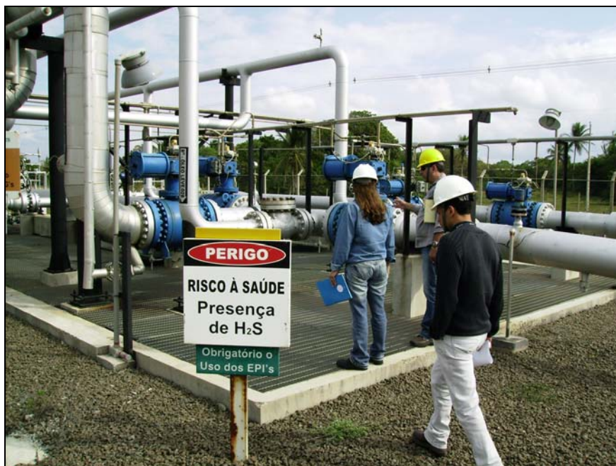
Foto 2 – Scraper de entrada
