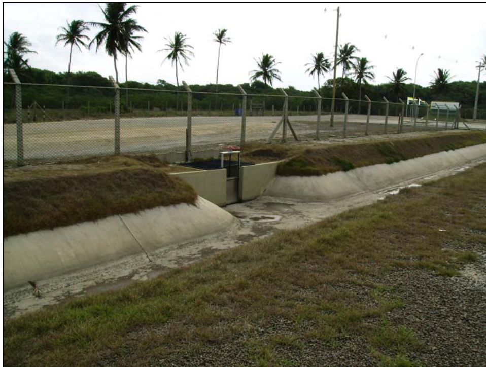
Foto 16 – Canaleta de drenagem pluvial com vertedouro para manguezal
