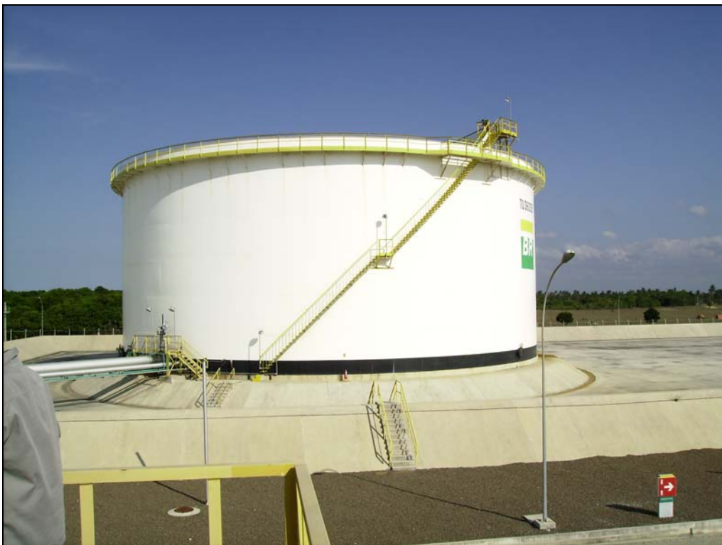
Foto 4 – Tanque de teto flutuante
