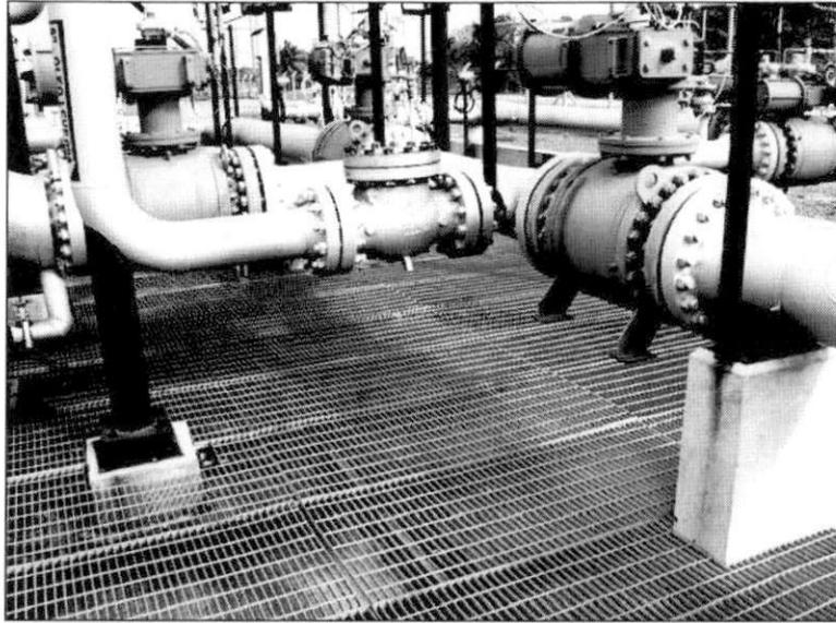
Foto 3 – Válvula SDV no *scrapper* de entrada
