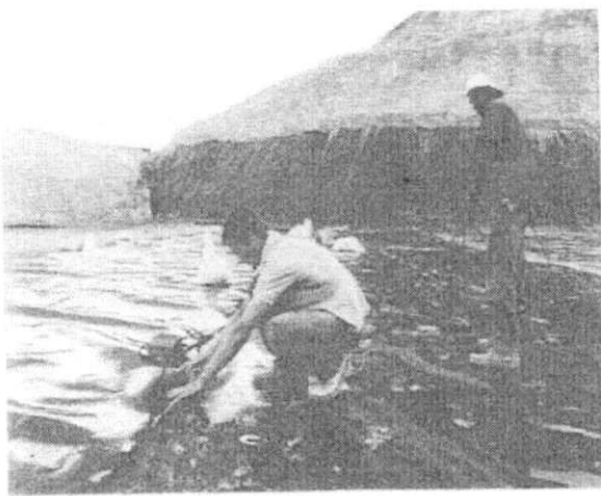
Impermeabilização com geomembrana de PEAD
