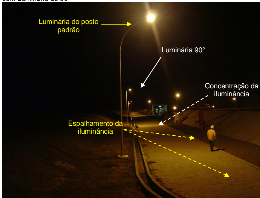
Figura 5.3 – Diferenças da Iluminação Provocada Pelo Poste Padrão e Pelo Poste com Luminária de 90°
