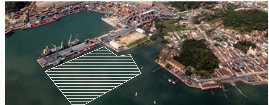
Vista aérea da área a ser dragada do píer do TESC
