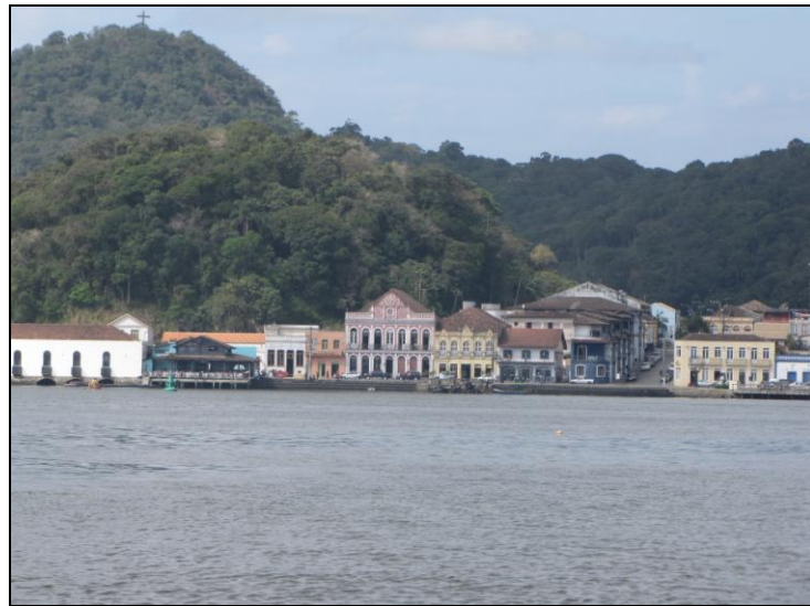
Figura 5.148– Vista dos prédios históricos
