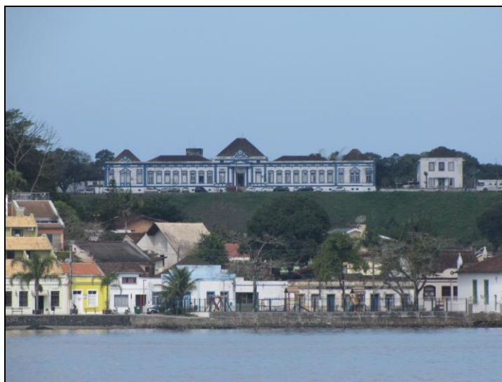
Figura 5.145 – Vista do Hospital de Caridade
