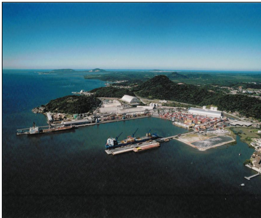
Figura 5.160 - Porto de São Francisco do Sul, vendo-se ao centro o Berço 301 e a estrutura da TESC em fase de preparação do terreno (aterro). (Foto cedida por Ambient).
