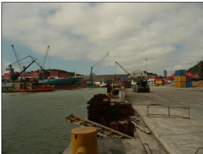
Figura 5.163 - Pátio do Porto de São Francisco do Sul (ALVES, Out./2011).
