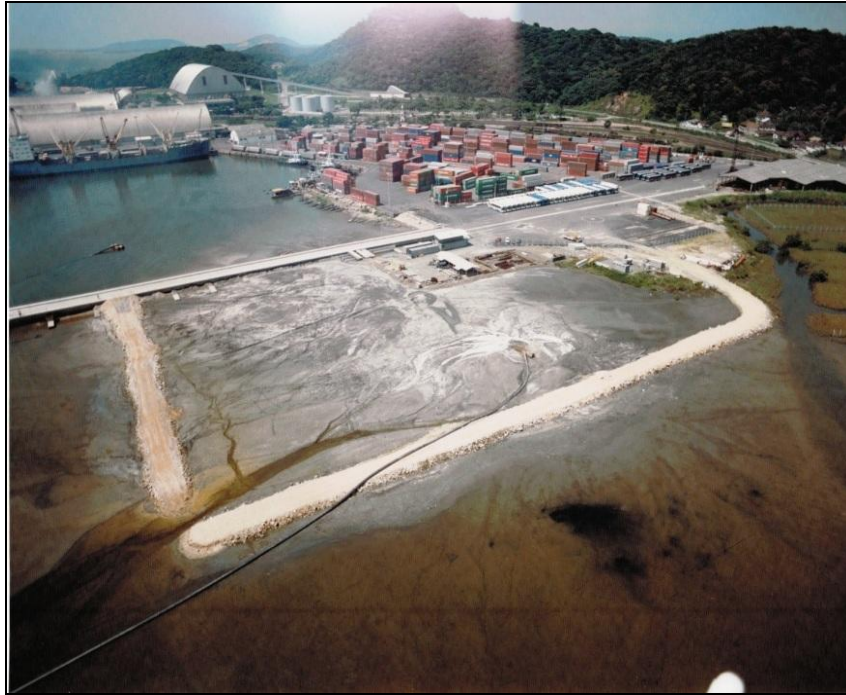
Figura 5.161 - Área das instalações da TESC em fase de preparação do terreno (aterro), vendo-se a foz do rio da Pedreira à direita. (Foto cedida por Ambient).
