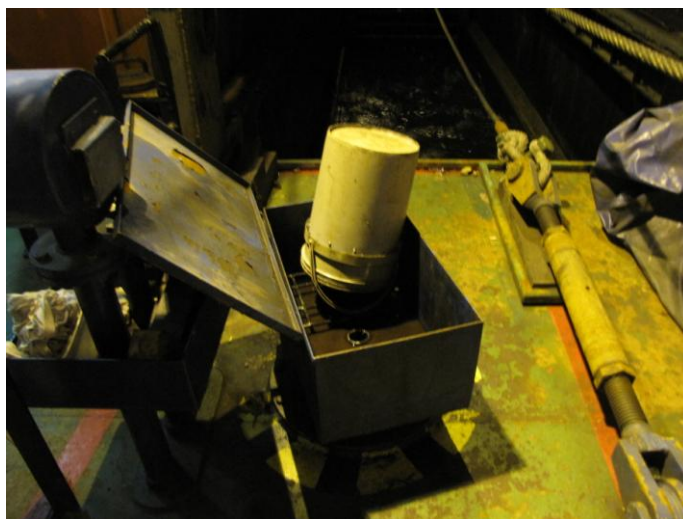
Figura 2.7 – Tanque de armazenamento temporário para efluentes oleosos
