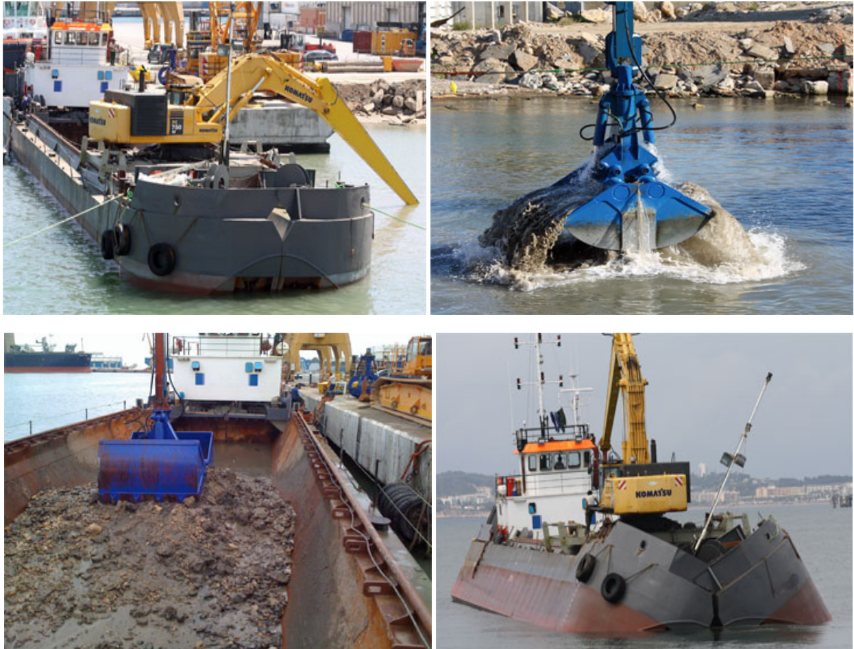
Figura 14. a) Escavadeira hidráulica instalada sobre barcaça; b) Detalhe da concha retirando material; c) Colocação dos sedimentos no interior da cisterna; d) abertura lateral da barcaça para descarga do material
