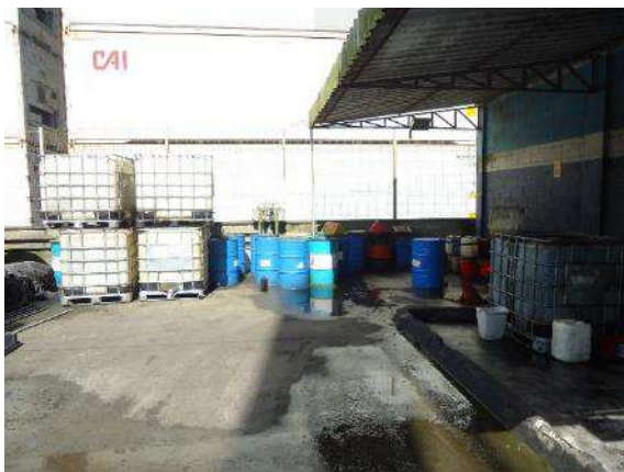
Visão geral da área de manuseio e descarte de óleo
