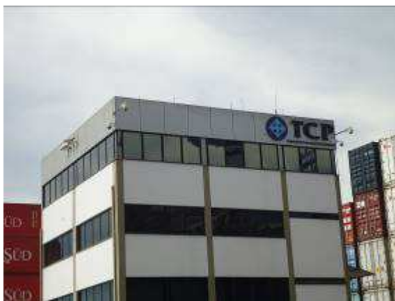
Câmeras de monitoramento na central de controle
