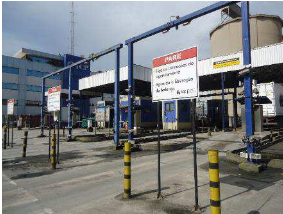
Visão geral do acesso de caminhões
