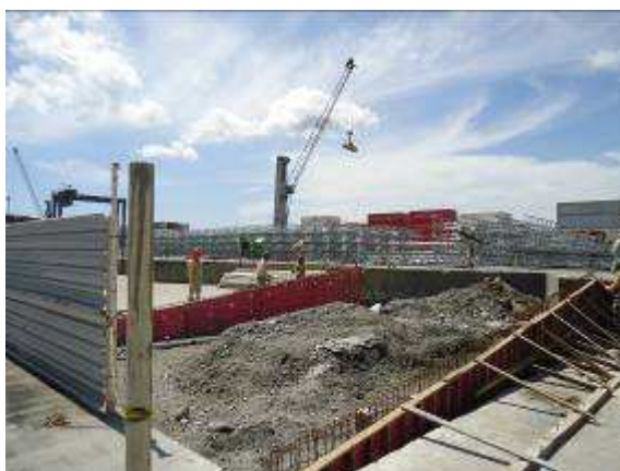
Vista parcial da construção do novo Armazém
