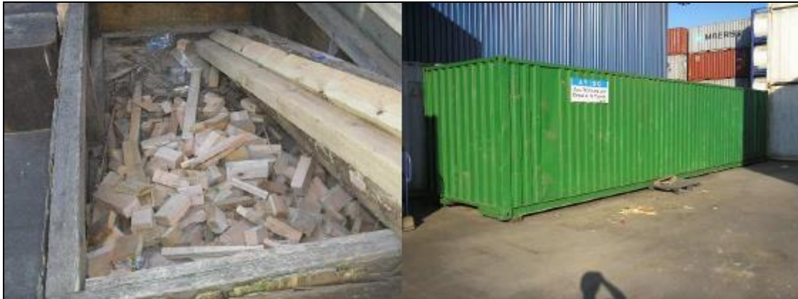
Figura 13. Caçambas localizadas próximo aos locais de geração do resíduo: área de armazenamento de madeira.
