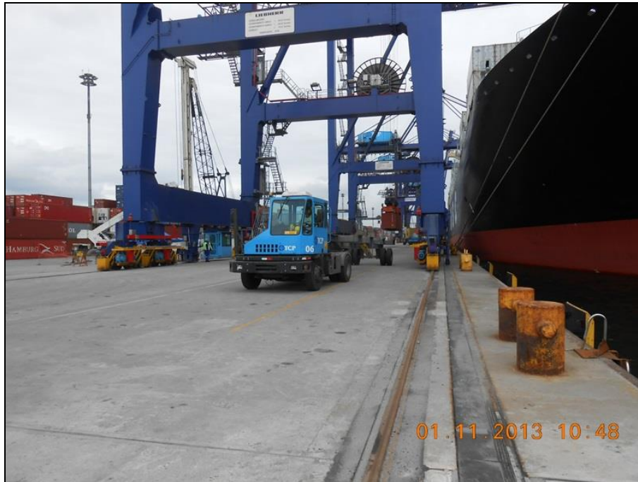
Figura 56. Proximidades dos pontos #6 e #7. Áreas de operação constante de caminhões e portêineres.
