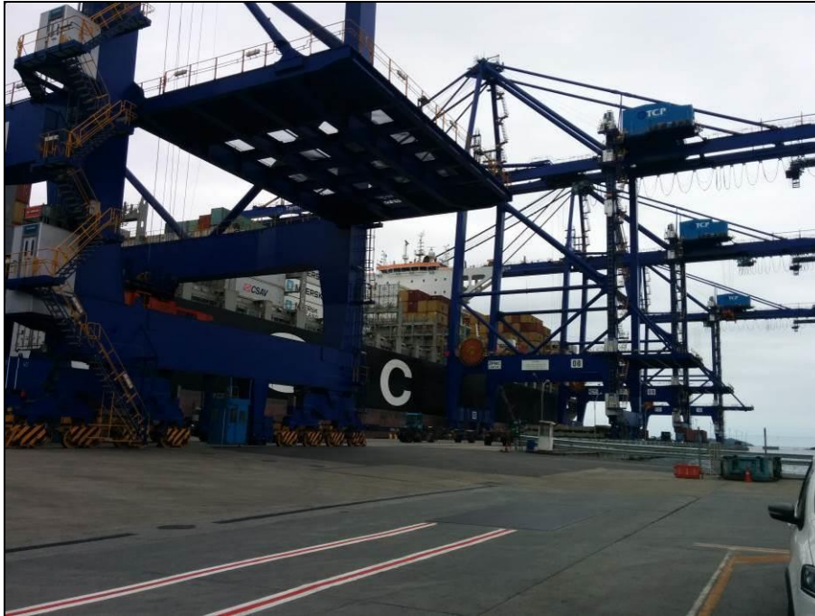
Figura 5. Operação no novo berço 217 do cais ampliado.
