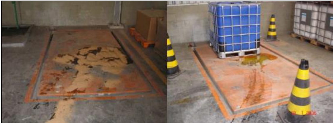
Figura 16. Área dentro do Armazém Alfandegado (cargas fiscalizadas ou com vazamentos).
