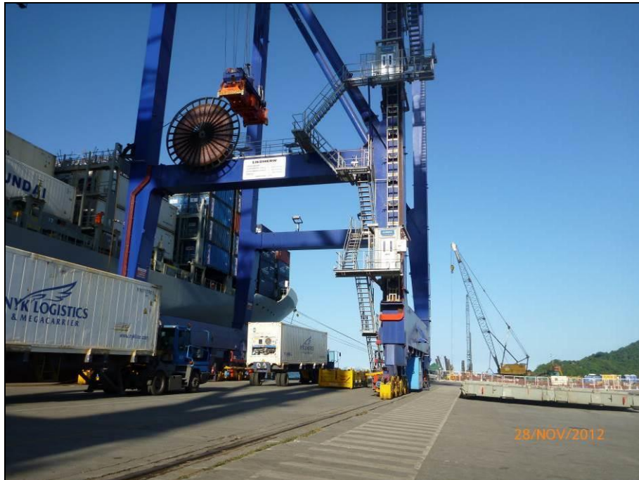
Figura 54. Ponto #6 – equipamentos localizados no cais do TCP. Área de movimentação de contêineres.
