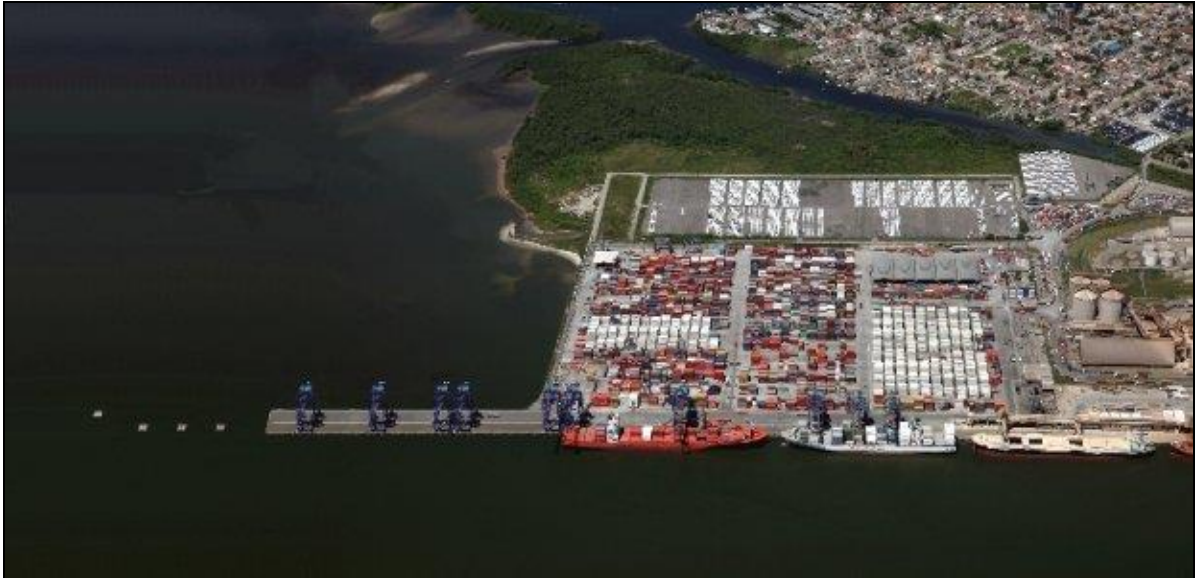
Figura 4. Layout da estrutura do TCP após conclusão da instalação do cais leste.
