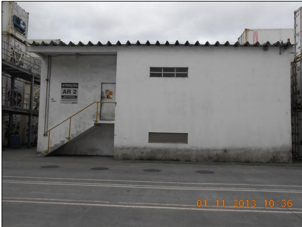
Figura 14. Subestação Transformadora ST2.
