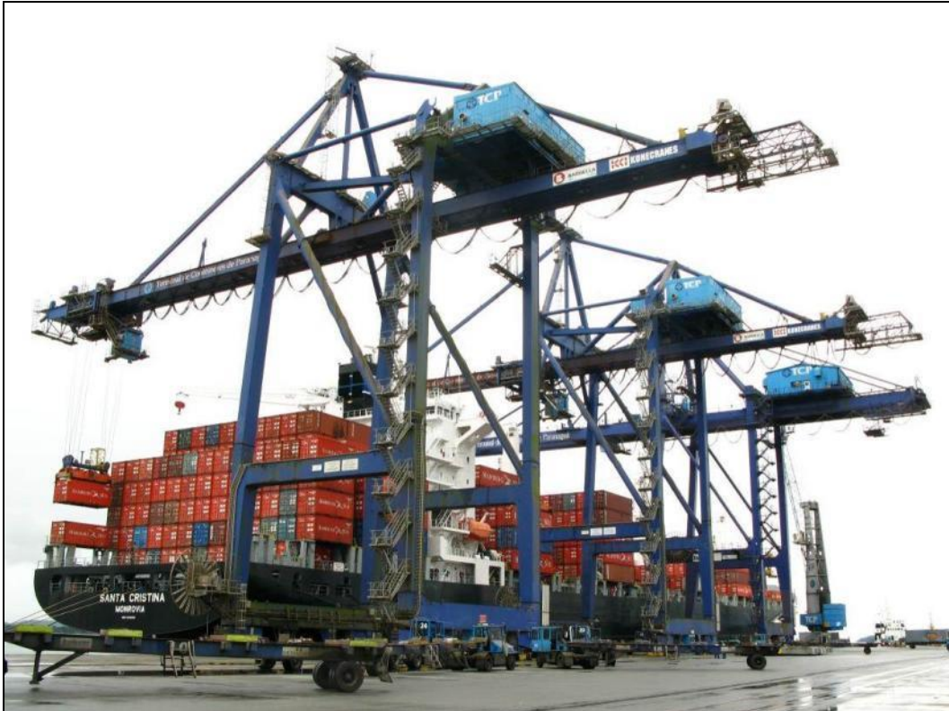
Figura 25. Portêineres tipo Post-Panamax em operação no TCP. Fonte: TCP (2012).
