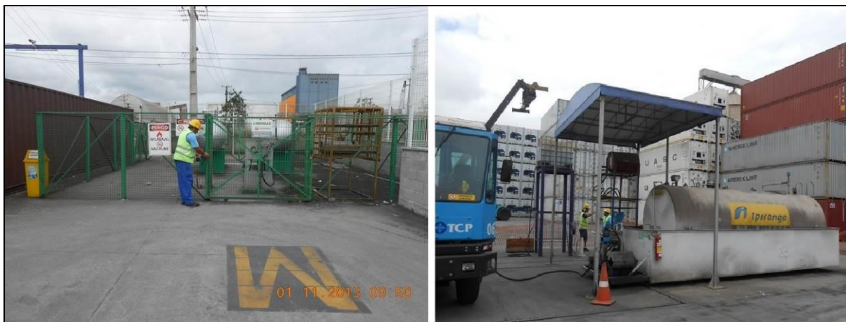
Figura 19. Central de Gás (E) e Sistema de Abastecimento de Combustível (D).
