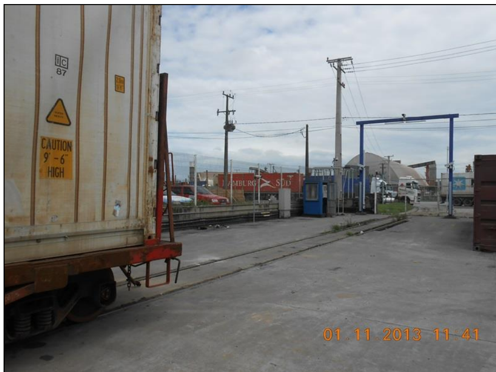
Figura 18. Acesso ferroviário ao TCP.
