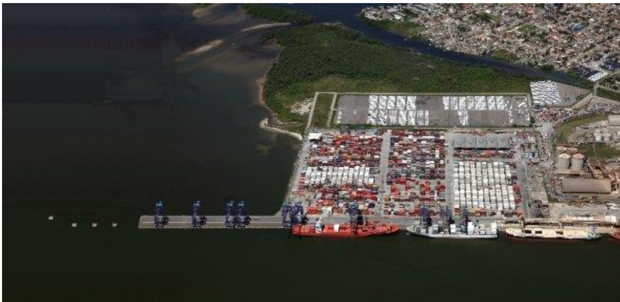
Figura 3. Vista aérea atual do TCP, com a projeção da ampliação do cais recentemente concluído.
