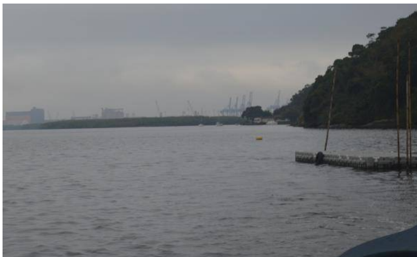
Figura 136 Complexo de Paranaguá visto a partir da TI Cotinga. No lado direito as estruturas da TCP. Julho de 2016.
