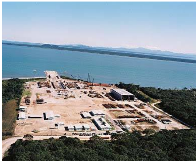
Figura 126 – Estrutura do canteiro de obras da TECHINT.
