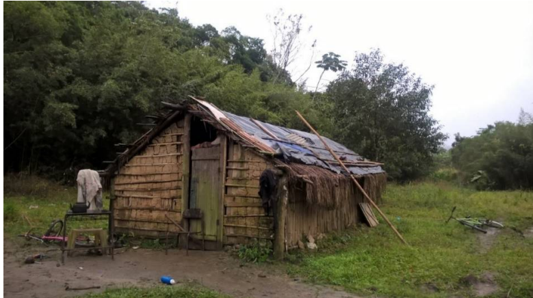
Figura 97 Residência de Taipa. TI Ilha da Cotinga.
