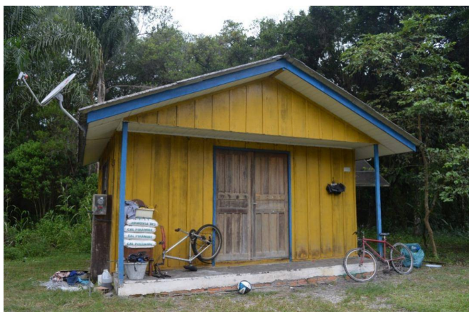
Figura 101 Construções na TI Sambaqui. Tekoa Karaguata Poty.
