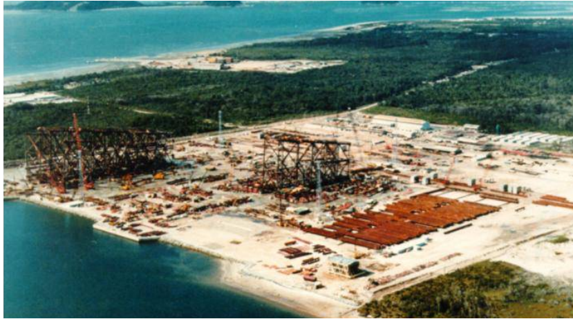
Figura 127 – Registro fotográfico do estaleiro na década de 1980. Fonte: EIA/RIMA, 2011 - Licenciamento Ambiental para as Obras de Readequação e Dragagem de Cais.
