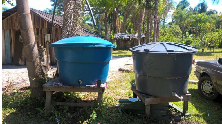
Figura 98 Reservatórios para abastecimento de água potável na TI Sambaqui. Tekoa Karaguata Poty
