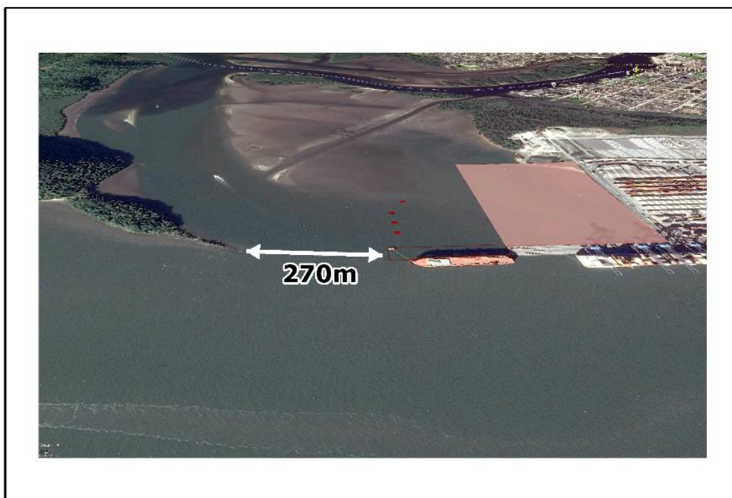
Figura 23 Projeto de complementação das obras de ampliação da TCP, onde se observa a seção livre de 270 metros no canal da Cotinga.
