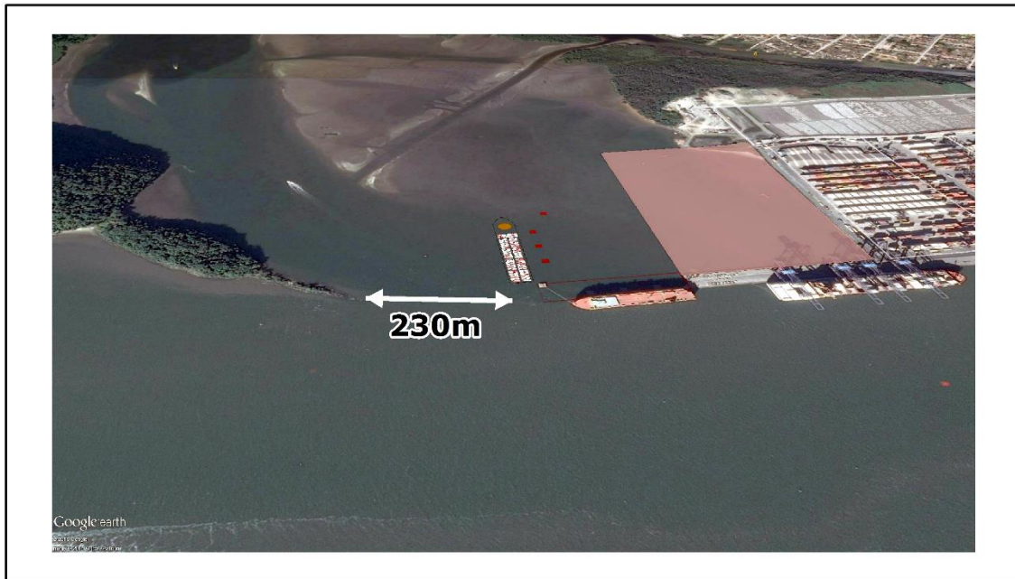
Figura 14. Seção livre do canal da Cotinga com 230 metros. Observa-se o navio atracado nos novos dolphins, oportunidade que haverá uma redução de 40 metros na seção do canal, com a atracação de um navio roll on-roll off .
