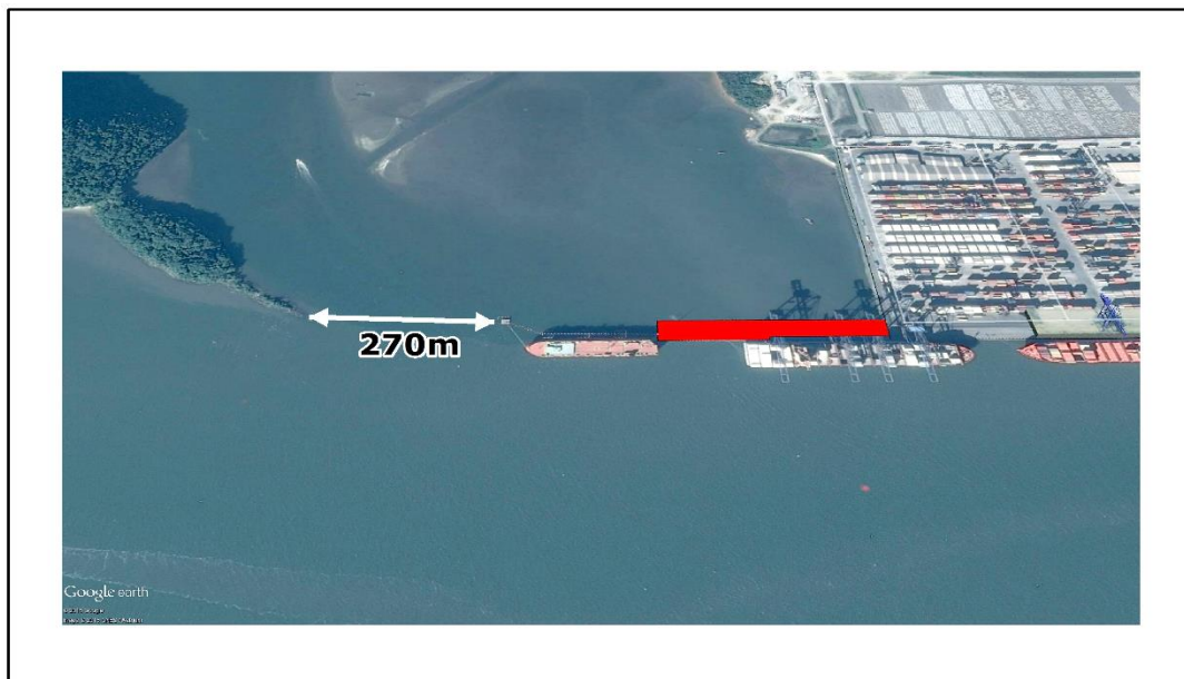
Figura 12. Ampliação do cais leste com a diminuição da seção livre do canal da Cotinga para 270 metros.
