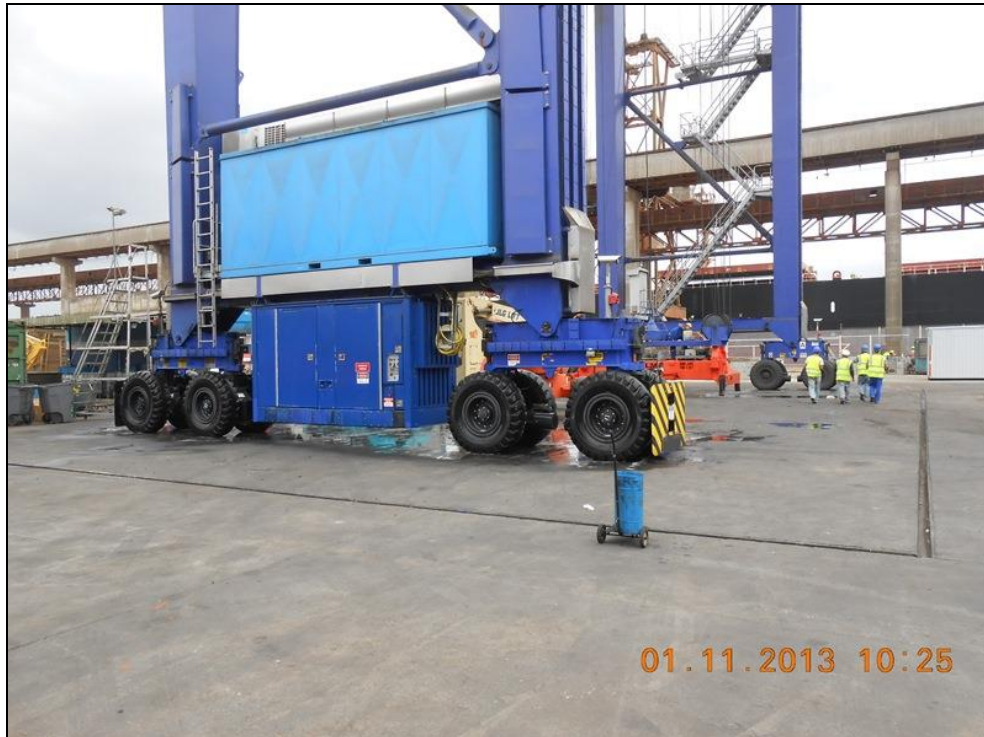
Figura 26. Área para lavação de equipamentos cercada com canelatas de drenagem.
