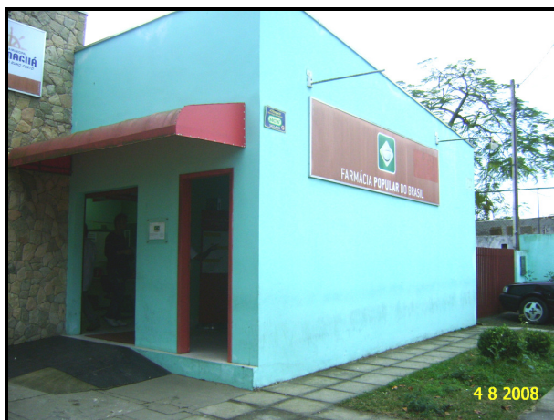
Figura 303 - Imóvel que abriga a Farmácia Popular em Paranaguá.
