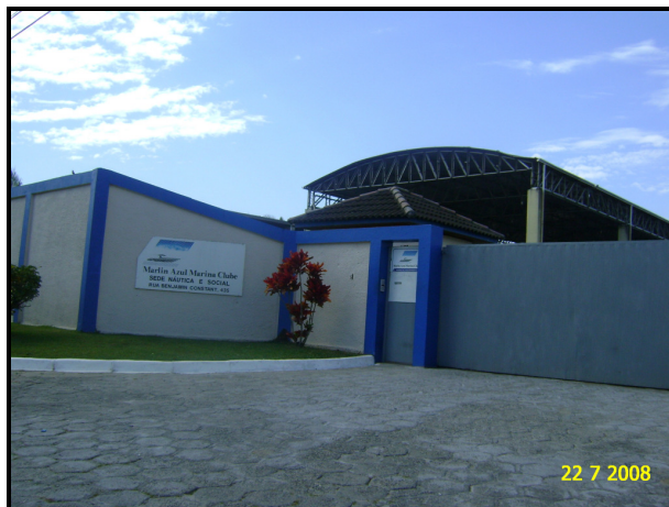
Figura 363 - Fachada da marina Marlin Azul em Paranaguá.
