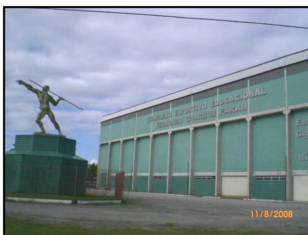
Figura 311 - Vista da entrada do Complexo Esportivo.
