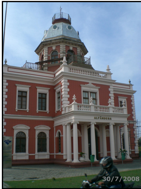
Figura 402 - Prédio da Alfândega.
