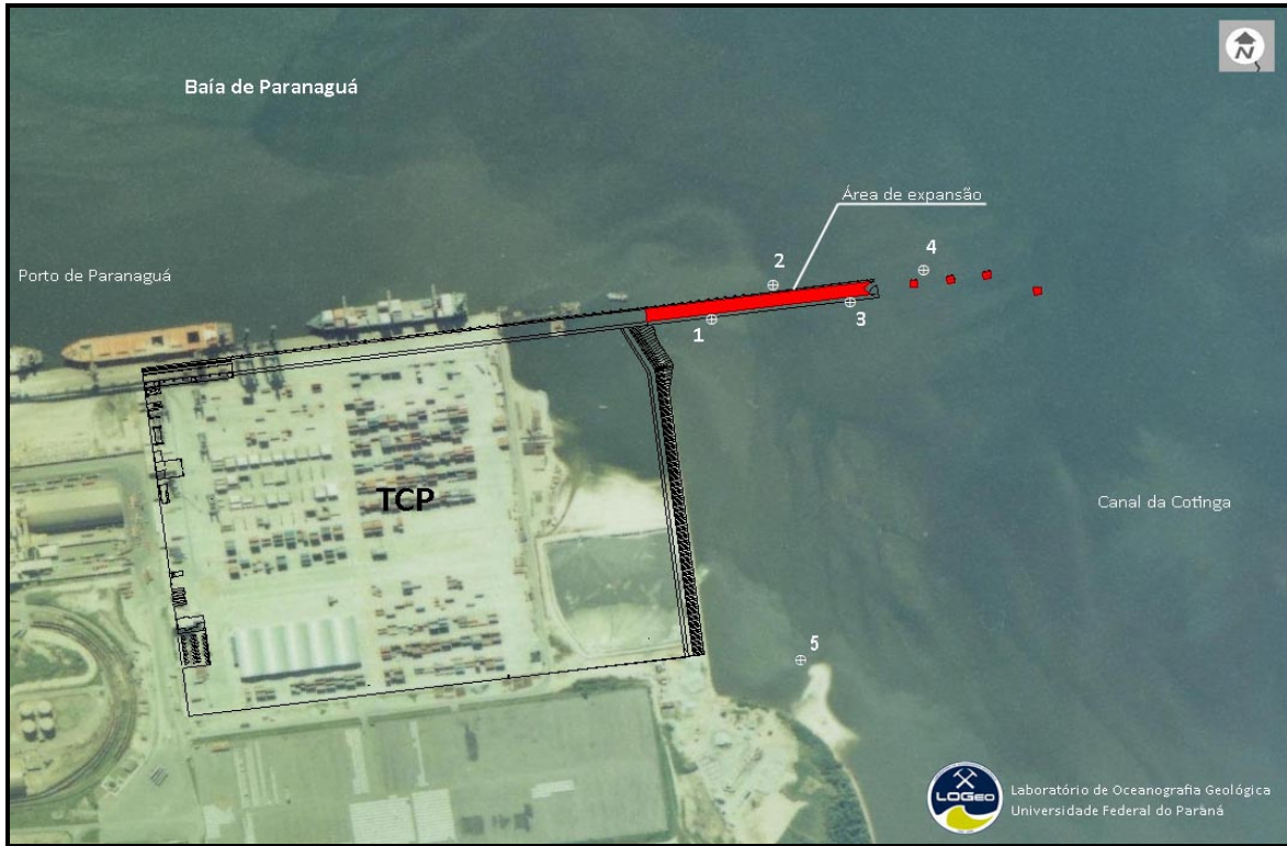
Figura 169 – Imagem da ADA do empreendimento com a localização dos cinco pontos de coleta.
