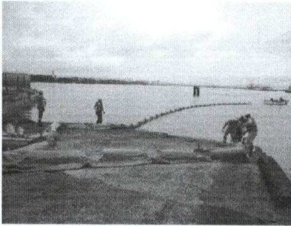
Figura 16 – Lançamento da barreira de contenção na água: Figura 17 – Cerco da mancha de óleo, uma ponta fixa no cais e a outra puxada pela lancha.
