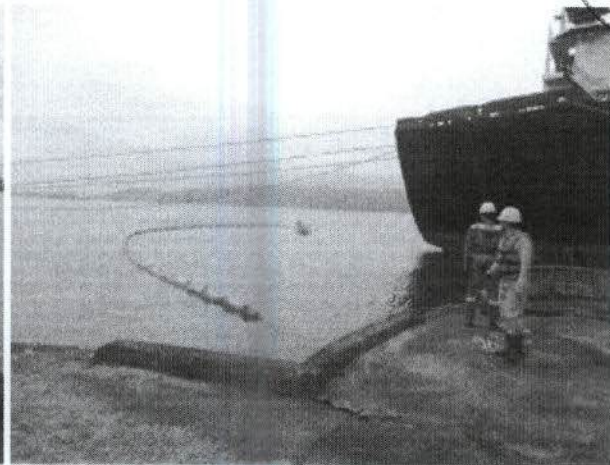
Figura 16 – Lançamento da barreira de contenção na água: Figura 17 – Cerco da mancha de óleo, uma ponta fixa no cais e a outra puxada pela lancha.
