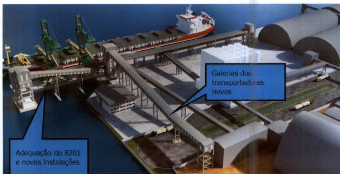
Figura 3: Maquete digital do projeto de adequação do B201. Fonte: Projeto Executivo Modernização B201 Adequação B201 Lado Oeste, Memorial Descritivo Civil, EXE ENGENHARIA.
