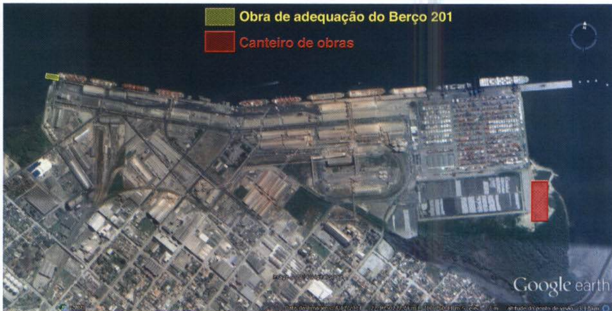
Figura 25: Localização da área destinada para o canteiro de obras.
