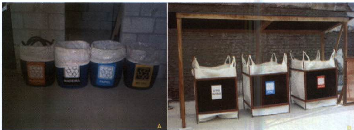
Figura 29: Formas de acondicionamento inicial de resíduos de construção: A (bombonas sinalizadas) e B (big bags).
