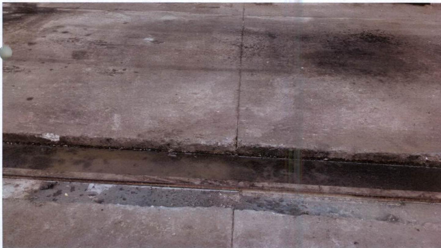
Figura 21: Acúmulo de substância em fermentação nas canaletas de drenagem.
