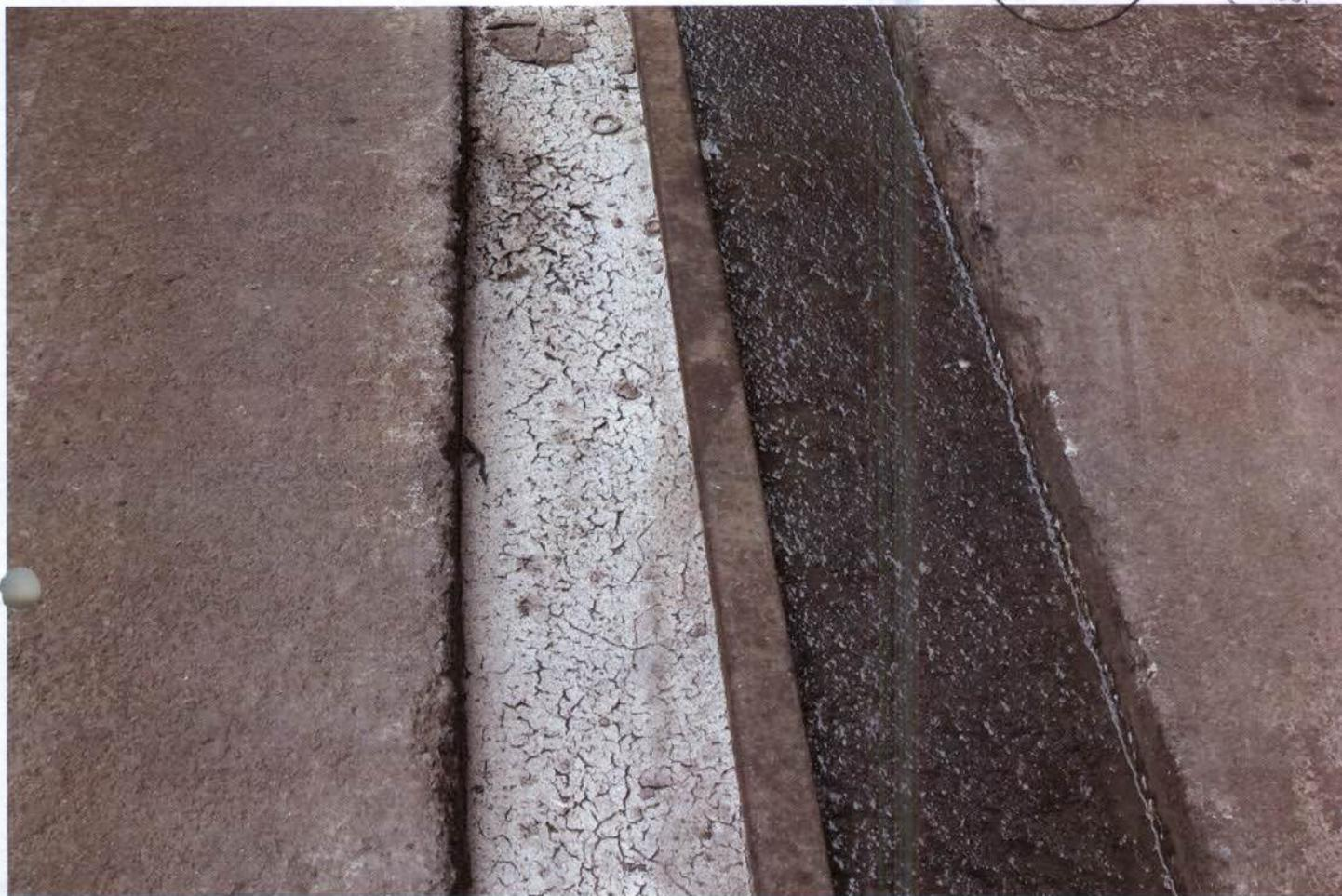
Figura 20: Acúmulo de substância em fermentação nas canaletas de drenagem.
