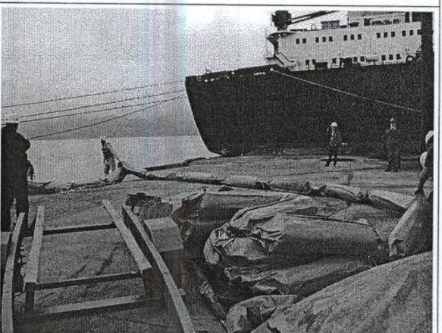
Foto 12: Montagem da barreira de contenção.
