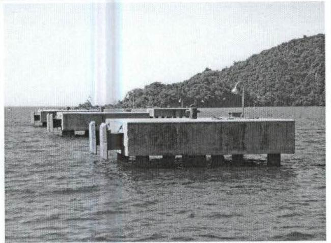
Figura 17: visão em aproximação dos dolfins, pode-se notar as estacas de sustentação e as estruturas de acostagem e de energia elétrica, já com sinais de utilização. (UTM 22J 751587 / 7177272)
