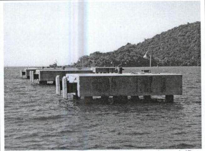
Figura 9: visão em aproximação dos dolfsins, podemos notar as estacas de sustentação e as estruturas de acostagem e de energia elétrica, já com sinais de utilização.
