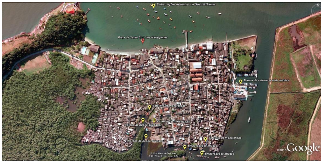
Figura 4.3.3.3.4.2-1: Santa Cruz dos Navegantes (Fonte: DTA Engenharia)
