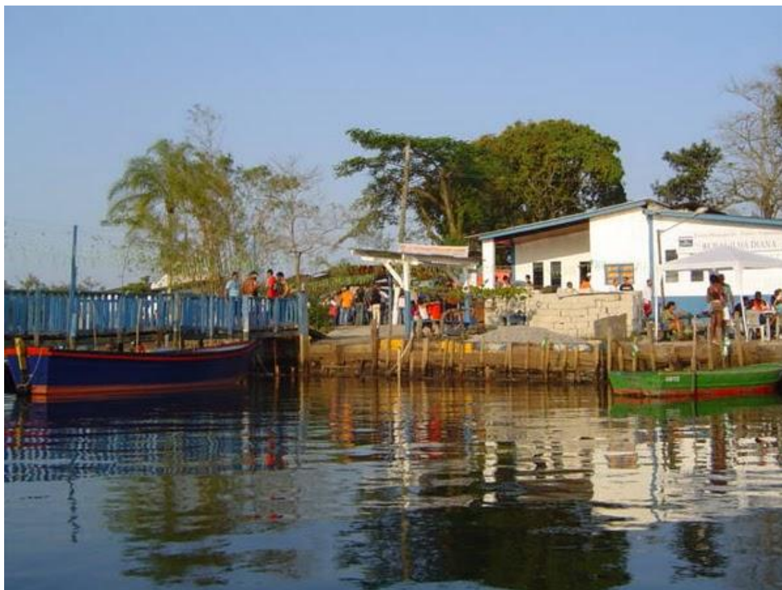
Figura 4.3.2.17.1.3-1: Atracadouro da Ilha Diana (Fonte: DTA Engenharia, foto Margareth)
