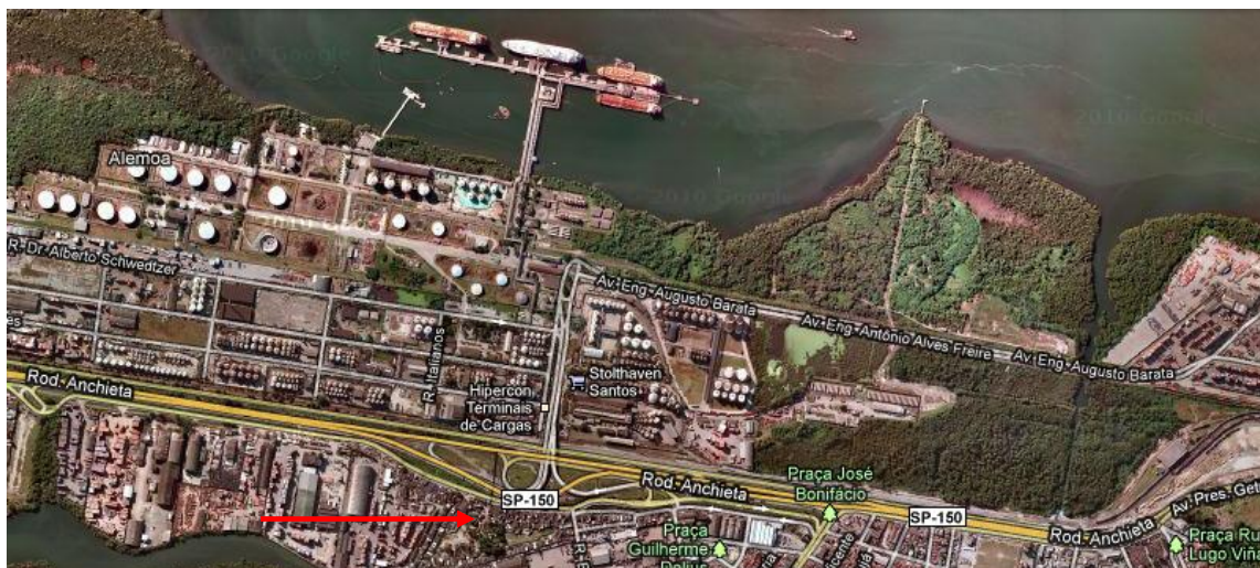
Figura 4.3.22-10: Acesso ao Viaduto da Alamoia (Fonte: Google Maps, 2011).
