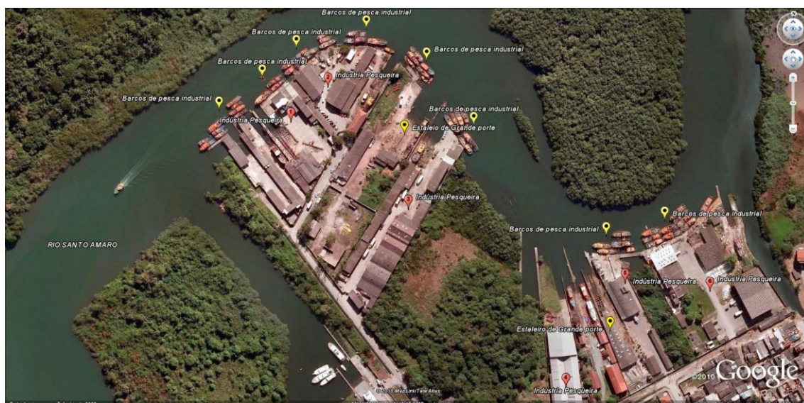
Figura 4.3.3.4.3-4: Rio Santo Amaro (Fonte: DTA Engenharia)
