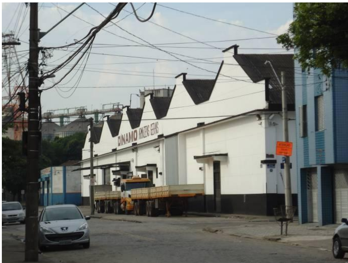
Figura 4.3.2.19.3-6: Terminal Retroportuário em área urbanizada -Armazém Geral Originário do comércio de café (Fonte: DTA Engenharia, foto Mauro Scazufca).
