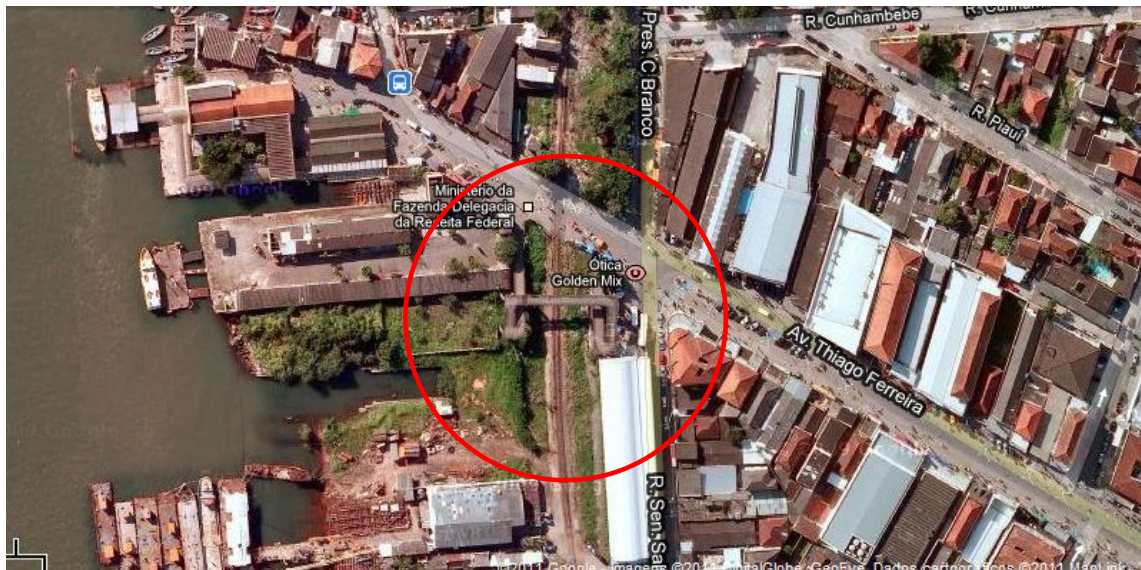
Figura 4.3.2.22-21: Passagem em nível na Avenida Thiago Ferreira (rodo-ferro) (Fonte: Google Maps, 2011).
