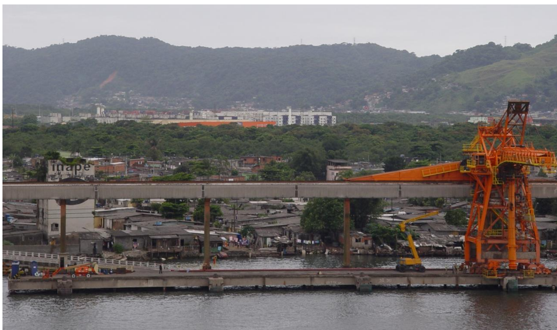
Figura 4.3.2.17.1.2-6: Vista de Sítio Conceiçãozinha, Guarujá: Moradia irregular e instalações portuárias (Fonte: DTA Engenharia, foto Margareth)
